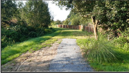
Abb. 2: Unterhaltungsweg mit freigelenktem Gewässerrandstreifen, 09.08.2021
