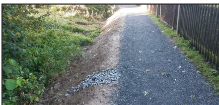
Abb. 1: Unterhaltungsweg mit Entwässerungsrinne, 25.08.2021
