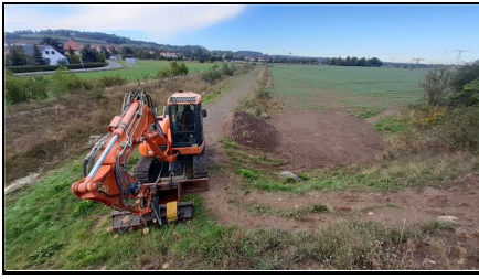
Abb. 2: Errichtung Rampen - Bau, 28.09.2020
