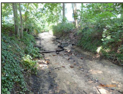
Abb. 35: Sohlverbau der Prießnitz unter abgelagertem Sand zwischen Bischofsweg und Hohensteiner Straße bei Trockenheit; 11.08.2015
