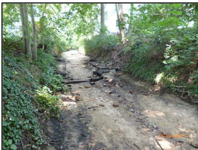
Abb. 32: Sohlverbau der Prießnitz unter abgelagertem Sand zwischen Bischofsweg und Hohensteiner Straße bei Trockenheit; 11.08.2015
