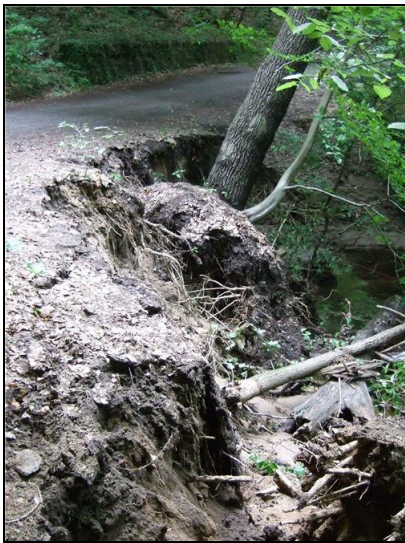
Abb. 41: Kolk am Uferweg nach dem Hochwasser im Juni 2013; 06.06.2013
