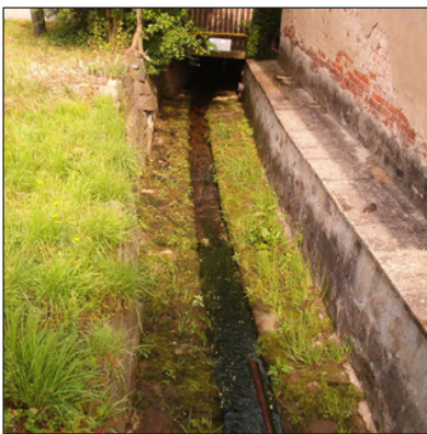
Abb.8: Kanalartig ausgebauter Abschnitt des Weißiger Dorfbaches in der Ortslage Weißig
