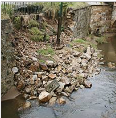
Abb.26: Prießnitz, Bereich Heidemühle/Radeberger Landstraße, zerstörte Ufermauer am Durchlass der Straße nach dem Hochwasser im August 2002
