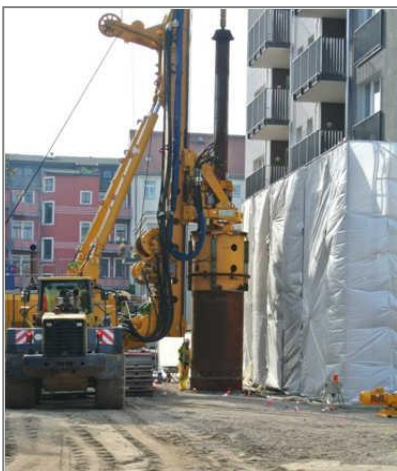
Bild 2: Abteufen der ersten Bohrung
