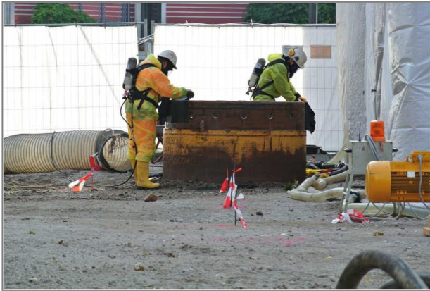
Bild 3 Arbeiten unter Vollschutz
