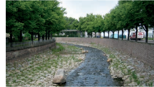
Neu ausgebaute Weißeritz in Dresden-Plauen
