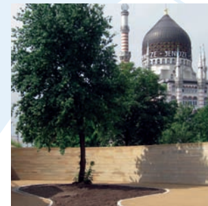
Hochwasserschutzmauer zum Schutz der Dresdner Innenstadt
