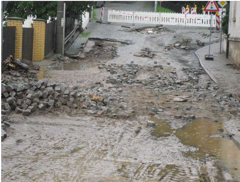
Abbildung 8: Schäden an der Weistropper Straße am Tännichtgrundbach nach dem Hochwasserereignis vom 27. Mai 2014, Foto: Dr. Korndörfer
