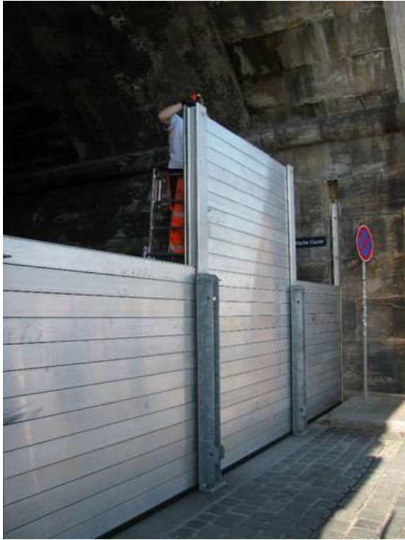
Abbildung 51: HWSA Altstadt, Probeaufbau des vollmobilen Verschlusses der Brühlschen Gasse (2016), Foto: Umweltamt, Landeshauptstadt Dresden
