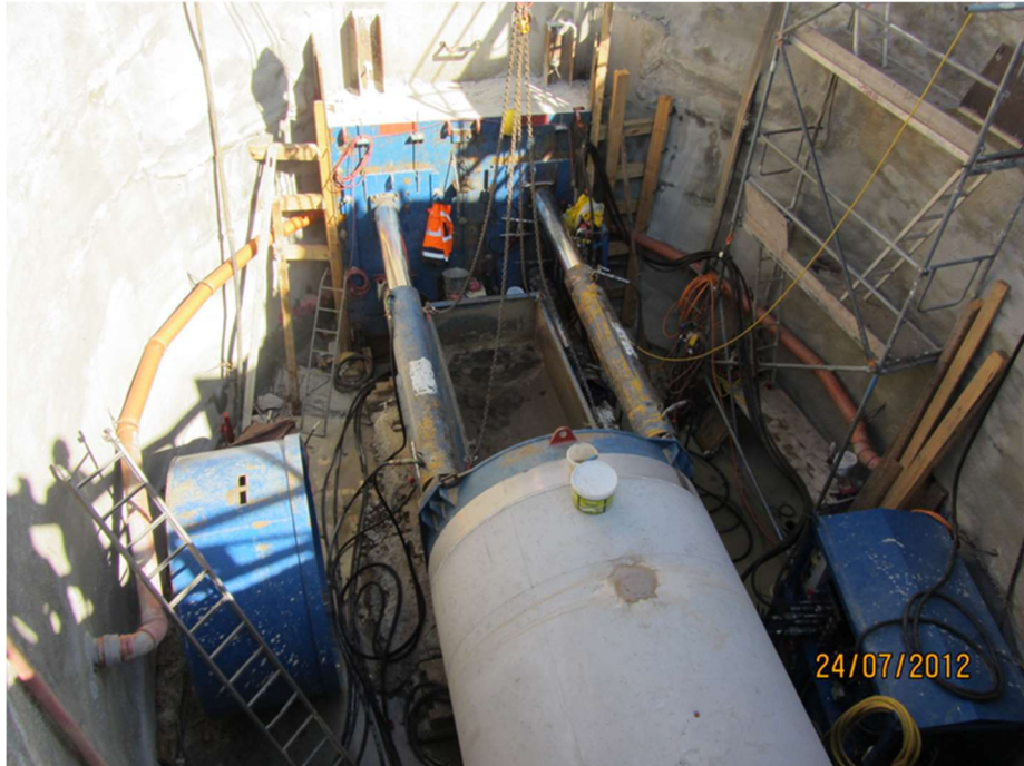
Abbildung 59: Sanierung des Altstädter Abfangkanals in geschlossener Bauweise 2012, Foto: Stadtentwässerung Dresden GmbH
