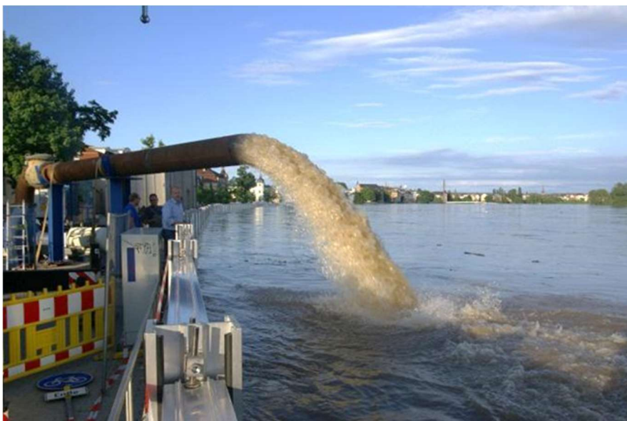
Abbildung 54: Provisorisches Hochwasserpumpwerk Kötzschenbroder Straße beim Elbe-Hochwasser 2013, Foto: Stadtentwässerung Dresden GmbH
