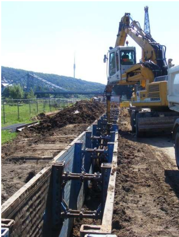
Abbildung 58: Sanierung des Altstädter Abfangkanals in halboffener Bauweise 2014, Foto: Stadtentwässerung Dresden GmbH
