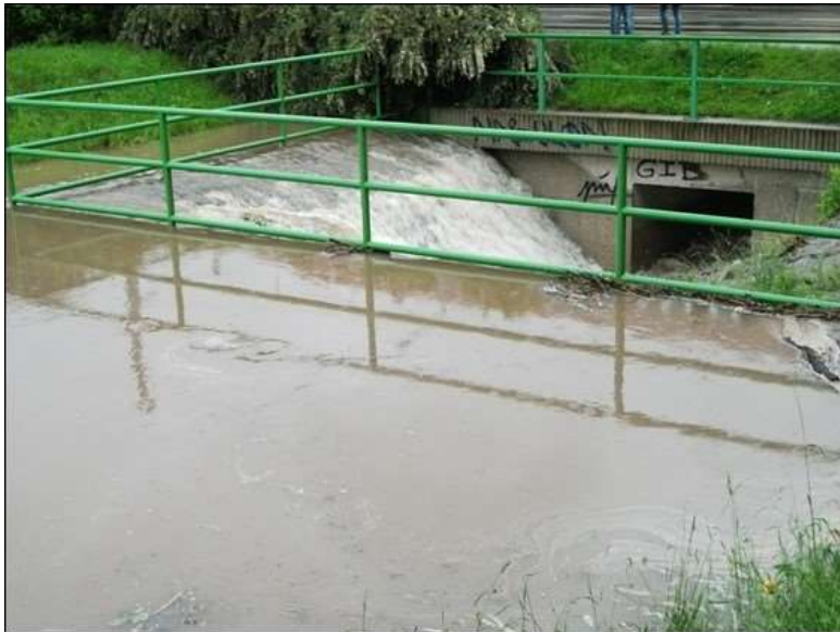
Abbildung 7: Hochwasserentlastung Hochwasserrückhaltebecken Kaitzbach 1 Hugo-Bürkner-Park, 3. Juni 2013, Foto: Umweltamt, Landeshauptstadt Dresden
