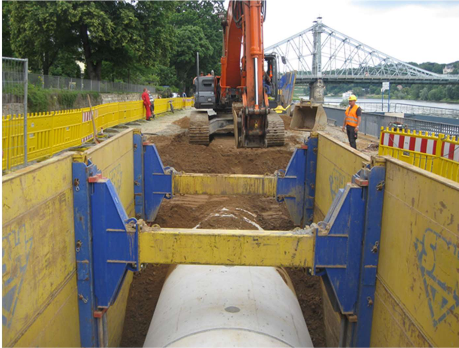
Abbildung 57: Sanierung des Altstädter Abfangkanals in offener Bauweise 2014, Foto: Stadtentwässerung Dresden GmbH
