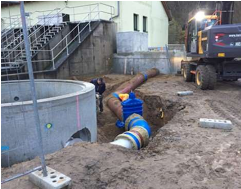
Abbildung 56: Nachrüstung des Hochwasserpumpwerkes Winkelwiesen 2017, Foto: Stadtentwässerung Dresden GmbH
