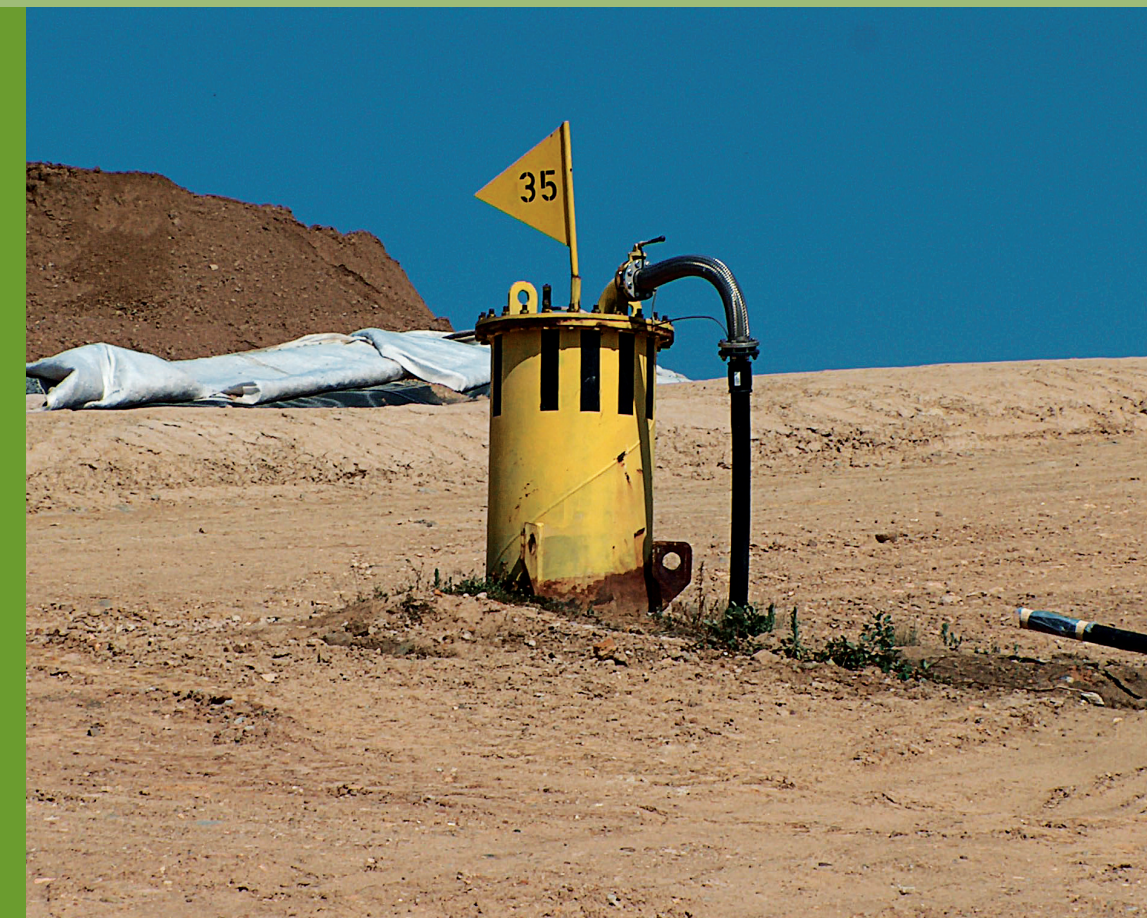
Einer von 24 Gasbrunnen zur Deponiegasverwertung
