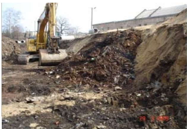
Bild 2: Umlagerung und Profilierung des Abfallkörpers der Hausmüll- und Bauschuttdeponie Proschhübelstraße im März 2005
