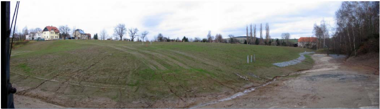
Bild 4: gesicherter Deponiekörper mit Entwässerungssystem und begrünter Oberflächenabdeckung der Baustoffdeponie Reitzendorf nach der Sanierung Dezember 2006
