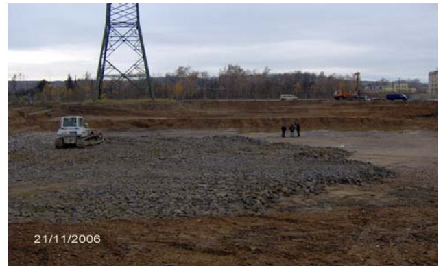
Bild 7: Rückverfüllung mit inertem Material
