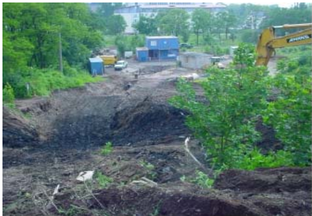
Bild 1: ungesicherte Deponieböschung mit offenen Abfallablagerungen zum Beginn der Sanierungsarbeiten Deponie Proschhübelstraße Juni 2004
