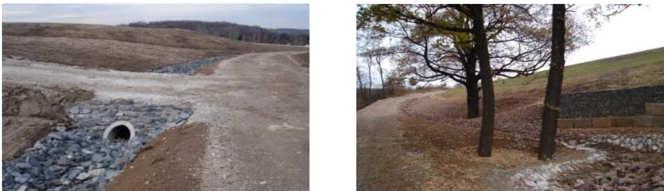
Bild 6/7: Oberflächenentwässerungssystem im Plateaubereich durch Randgraben (B.6) sowie am Böschungsfuß mit Schutz der Vegetation (B.7)
