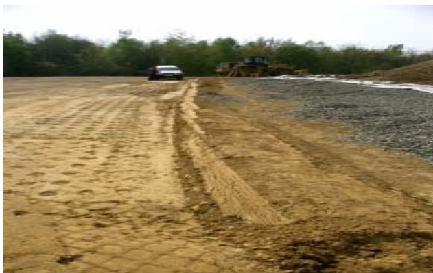
Bild 1: Aufbringen der Dichtungs- und Dränageschicht
