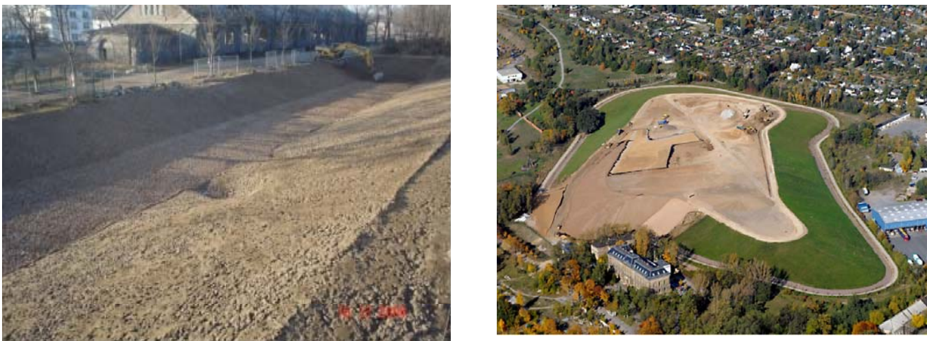
Bild 8: Aufbau des Sickerbeckens in Deponierandlage zur Versickerung des Oberflächenwassers
