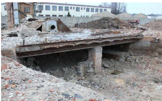
Bild 2: Abbruch und Entsorgung unterirdischer Gebäudeteile und verfüllter Keller
