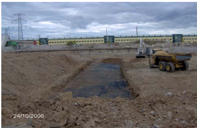
Bild 5: Schalöl unter den Produktionshallen
