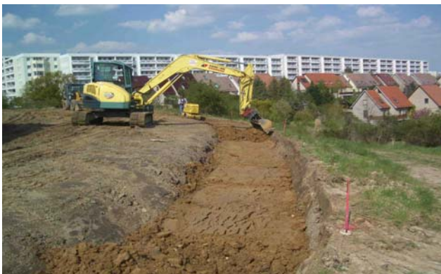
Bild 1: Bau Profilierung Oberfläche
