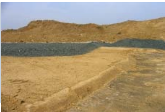
Bild 2: Aufbringen der Dichtungs- und Dränageschicht
