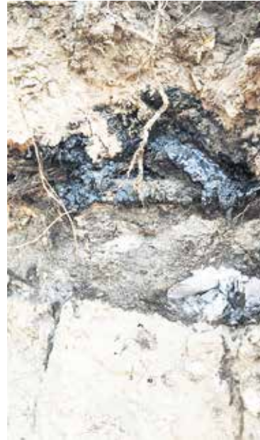
Bodenhorizont mit Teerverunreinigung von einer Dresdner Baustelle.
