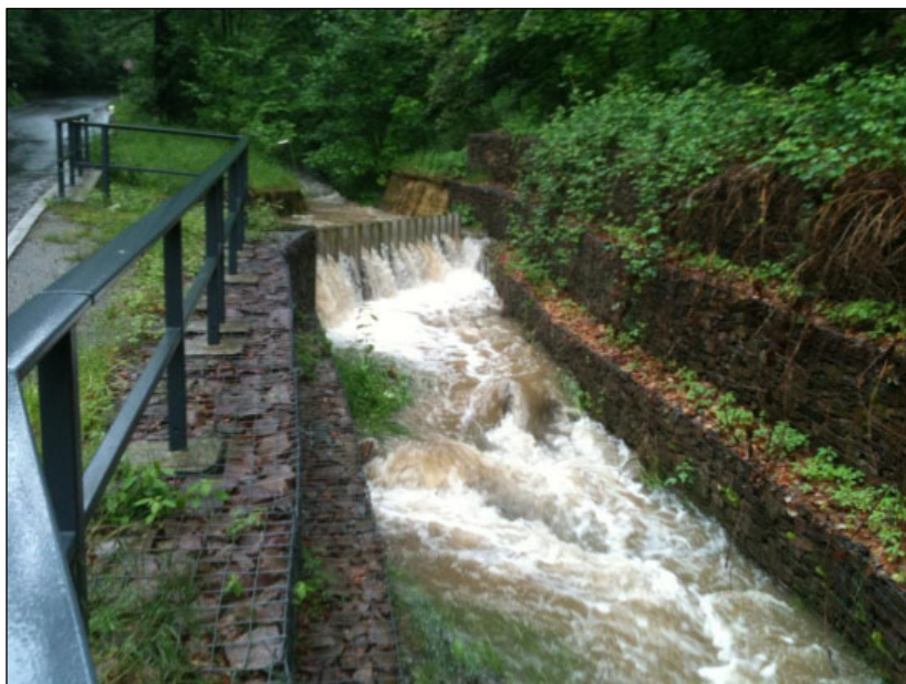
Abb. 9: Helfenberger Bach, Treibgutfang in Höhe Helfenberger Grund 8 b, 3. Juni 2013
