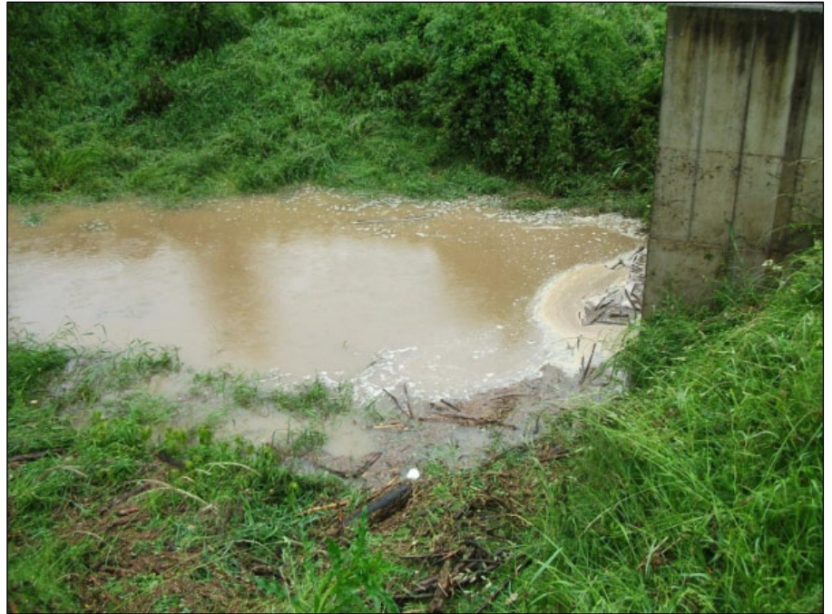
Abb. 13: HWRB Zschauke, 3 Juni 2013; am umgelegten Gras und an der Geschwemselinie an der HW-Entlastung kann man den Wasserstand in der Nacht abschätzen
