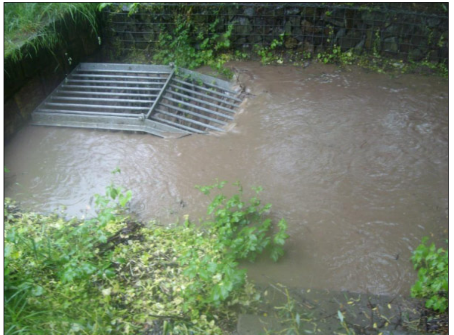
Abb. 45: Rückstau am zugesetzten Rechen Clara-Zetkin Straße, 2. Juni 2013
