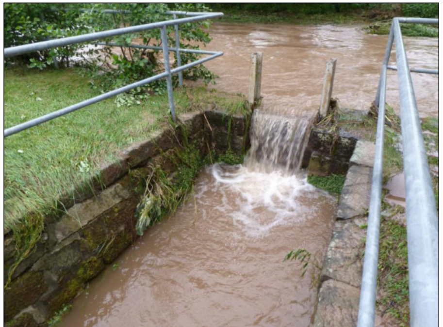
Abb. 25: Wehr Lockwitzbach/Lockwitz-Mühlgraben, 4. Juni 2013; am umgelegten Gras sieht man, dass der Bereich breitflächig vom Lockwitzbach überströmt wurde
