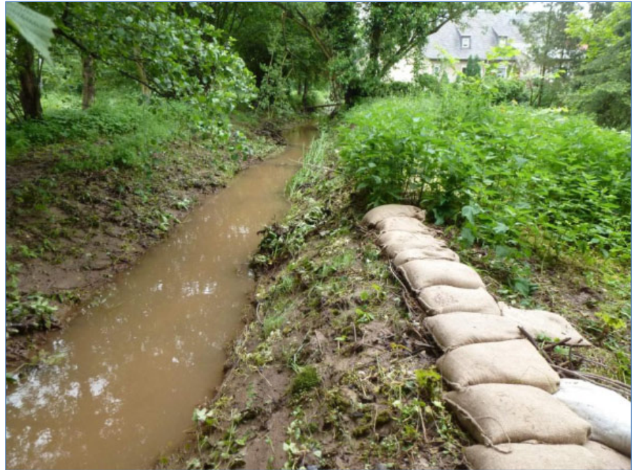
Abb. 26: Lockwitz Mühlgraben im Bereich Bedrich-Smetana-Straße, 4. Juni 2013; an der Übertrittsstelle wurden Sandsäcke verlegt
