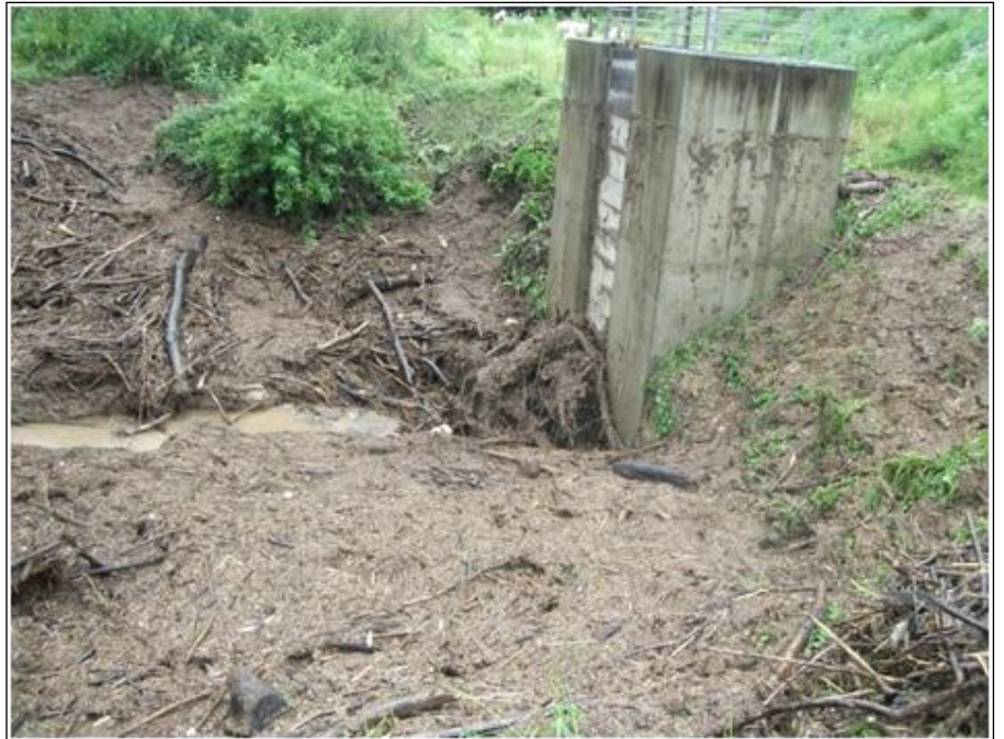
Abb. 19: HWRB Zschauke, durch wiederholte Starkniederschläge am 20./21. Juni und 25./26. Juni 2013 beschädigtes HWRB Zschauke, 29. Juni 2013
