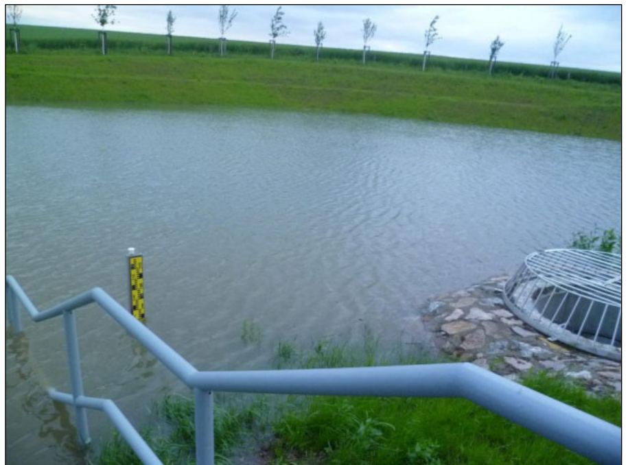
Abb. 38: Eingestautes HWRB Gompitzer Graben, 3. Juni 2013, am rechten Bildrand ist die Hochwasserentlastungsanlage
