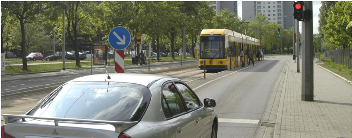
Bild 18: Überfahrbares Haltestellenkap (Haltestelle „Rottwerndorfer Straße“)
