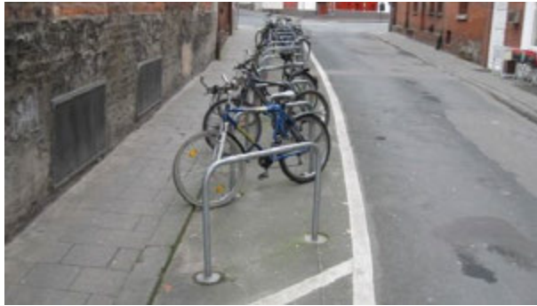
Abbildung 2.5 Beispiel für verschraubte Rahmenhalter (Lüneburg)
