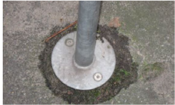
Abbildung 2.5 Beispiel für verschraubte Rahmenhalter (Lüneburg)
