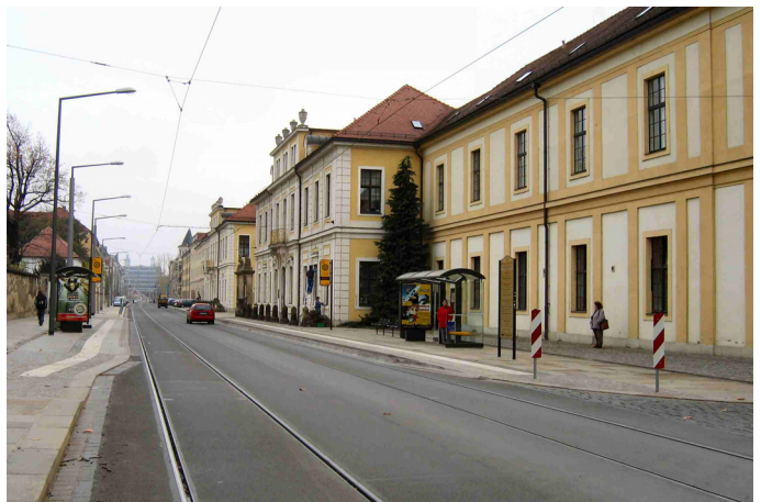
Abbildung 5: Haltestellenkap Krankenhaus Friedrichstadt: durch Verschwenken der Borde an das Gleis kann direkt von der Gehbahn in Straßenbahn oder Bus eingestiegen werden.
