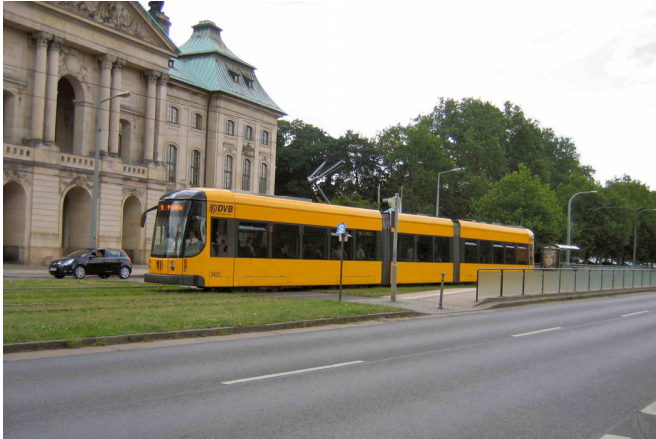
Abbildung 7: Haltestelleninsel Palaisplatz: Von der Insel, auf der die Fahrgäste warten und einsteigen, kann an beiden Enden die Straße überquert werden. Die Gleisanlagen werden durch das Rasengleis aufgewertet.
