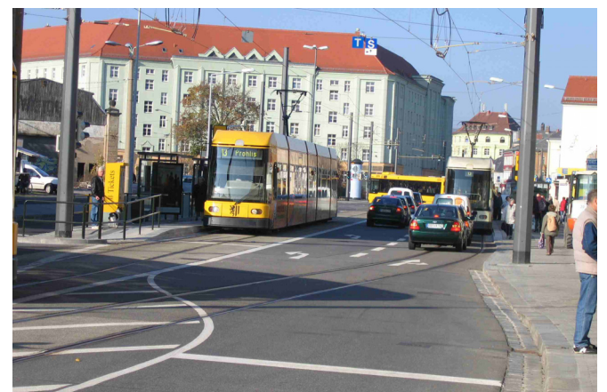
Abbildung 30: Leipziger Straße in Mickten (Blickrichtung Nord): Mit der Umgestaltung wurde die landwärtige Straßenbahn an die Gehbahn verschwenkt sowie die Haltestellen behindertengerecht hergestellt. Die Linksabbieger zwischen den Gleisen verbessern den Verkehrsablauf.
