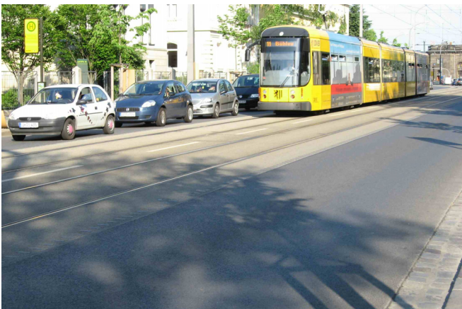
Abbildung 28: Antonstraße: Mit der Umgestaltung und dem Knotenpunktausbau wurden die gegenseitigen Behinderungen zwischen ÖPNV und Kfz-Verkehr beseitigt. Der Gleisbereich ist gestalterisch von der Fahrbahn abgegrenzt.
