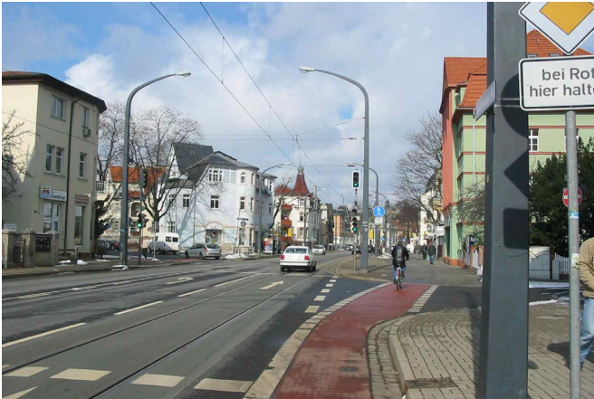
Abbildung 27: Haltestelle Großenhainer Straße/D.-Erleben-Straße in der Großenhainer Straße: vor der Haltestelle Linksabbieger zwischen den Gleisen. Durch das flächensparende Haltestellenkap kann Platz für Radfahrer und die Anlieferung auf der verbreiterten Gehbahn gewonnen werden.
