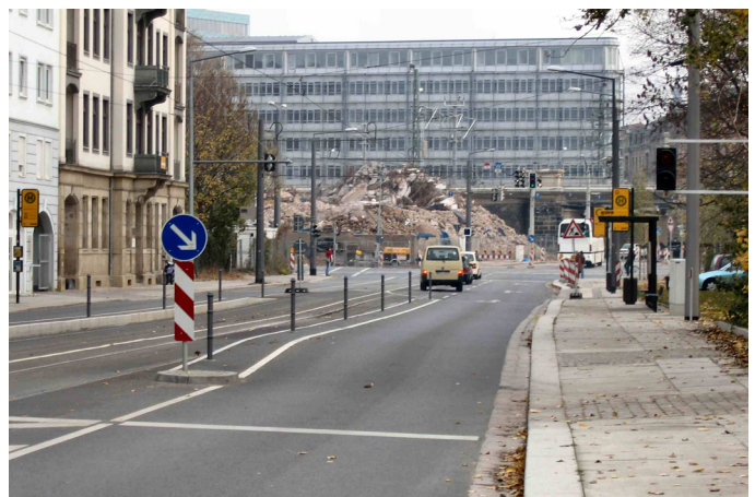
Abbildung 6: Bei der angehobenen Fahrbahn (hier Haltestelle Weißeritzstraße) wird die Fahrbahn im Bereich der Haltestelle erhöht. Die Fahrgäste warten auf der Gehbahn und können nach Einfahrt der Straßenbahn diese über die angehobene Fahrbahn bequem erreichen.
