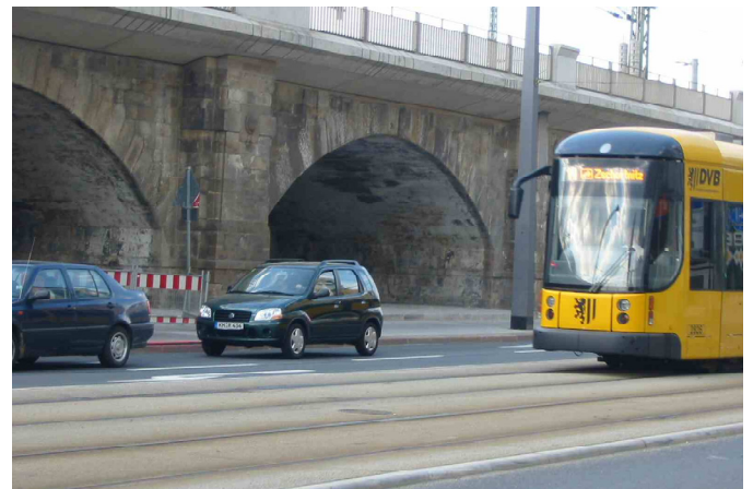
Abbildung 3: Mit dem Umbau der Könneritzstraße haben ÖPNV und Kfz-Verkehr nebeneinander Platz. Die Fahrbahn weist einen neuen Belag auf und die Straßenbahn einen eigenen Gleiskörper.
