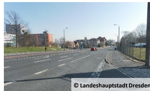
Fehlende bauliche Fassung im Bereich Kreuzung Julius-Vahlteich-Straße, Baumreihen fehlend
