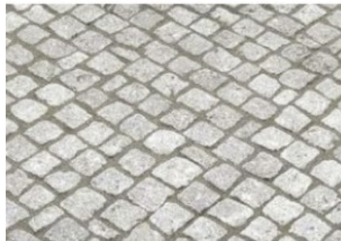
Abb. 2 Funktions- und Aufmerksamkeitsstreifen Granit-Kleinpflaster und Mosaikpflaster
