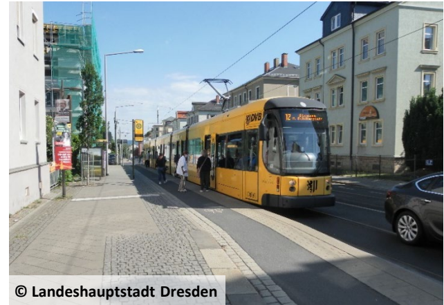
Beispiel Haltestelle mit angehobener Radfahrbahn
