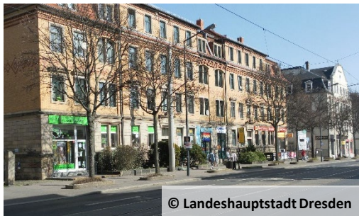
Straßenabschnitt mit Vorgarten und einseitiger Baumreihe
