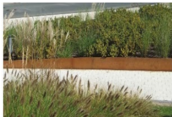
Abb. 3 Baumscheiben Baumscheiben der bestehenden Bäume werden z. B. durch Stahlkante neu gefasst
