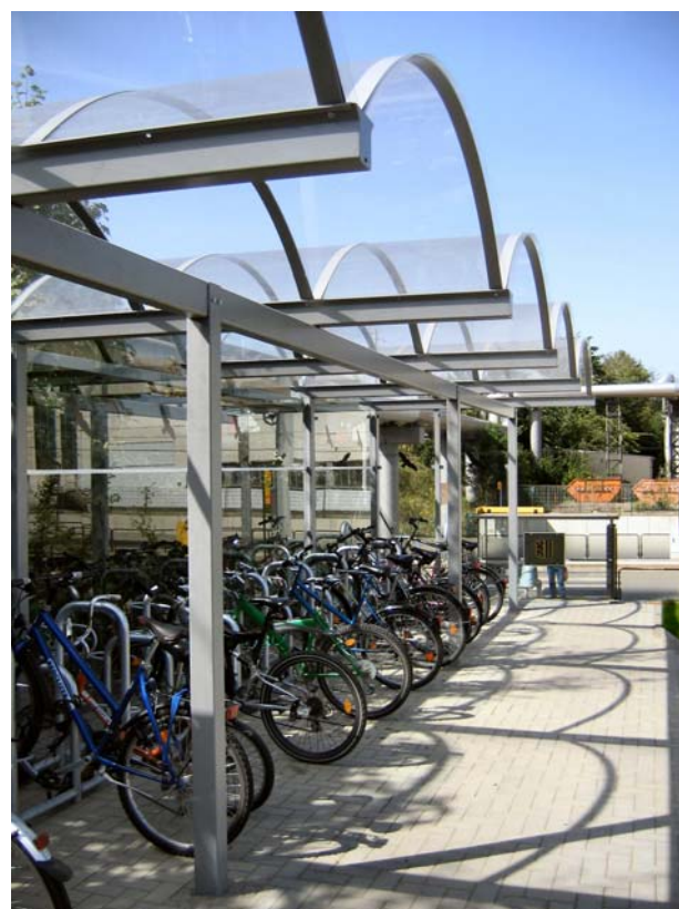
B & R-Anlage Dobritz
