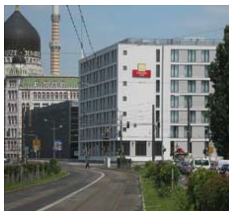
Hotelneubau Dresden Altstadt, Weißeritzstraße/Magdeburger Straße
