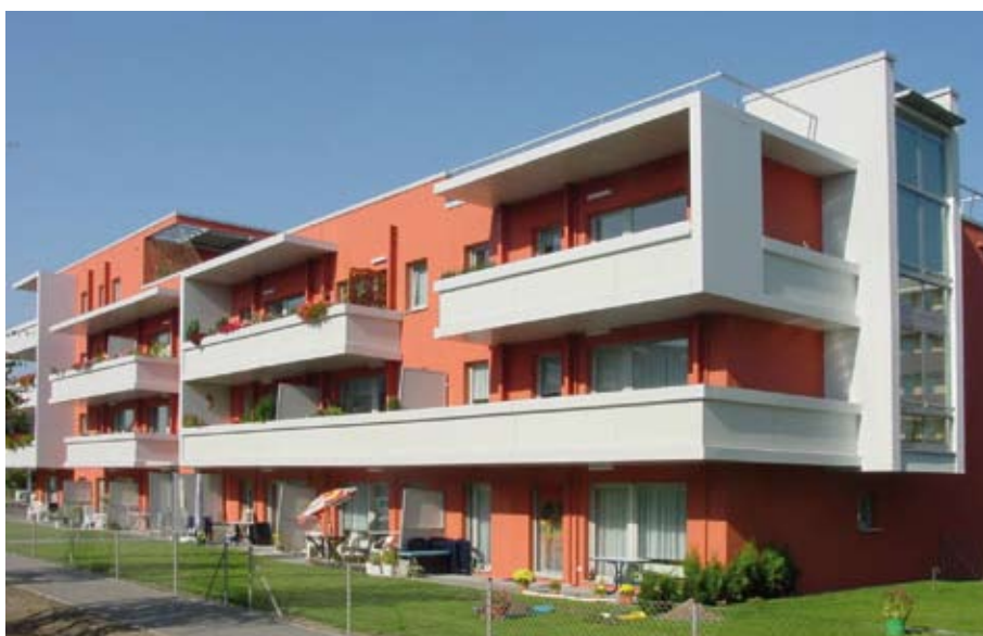
Teilrückbau Gorbitz, Kräutersiedlung
