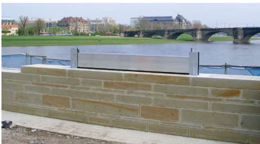
Hochwasserschutzanlage für Innenstadt (Altstädter Seite), Wilsdruffer Vorstadt und Friedrichstadt vor Elbhochwasser, Abschnitt Neue Terrasse
