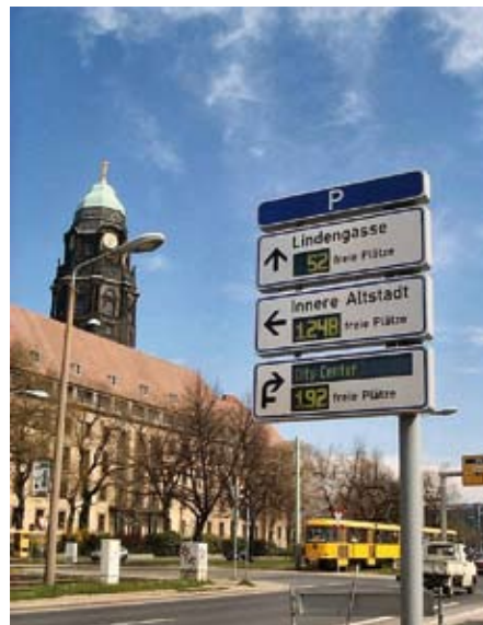
Parkwegweiser mit dynamischer Textzeile auf der Waisenhausstraße
