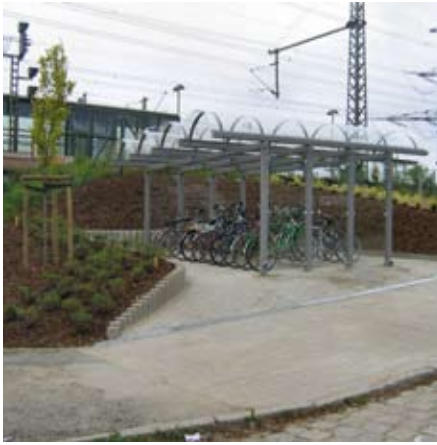
B+R-Anlage Haltepunkt Dresden-Zschachwitz
