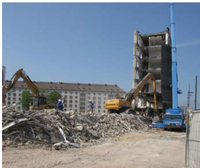
Erweiterung Einkaufszentrum Altmarkt Galerie – Abriss „Linde Haus“
