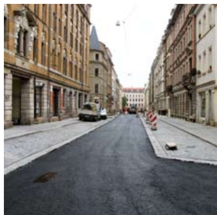
Ausbau Kamenzer Straße
