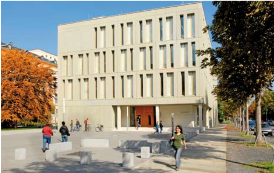
Bibliotheksneubau, Hochschule für Technik und Wirtschaft
