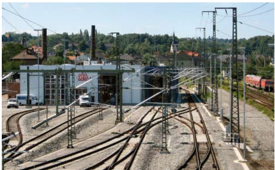
Neue Fahrzeugwerkstatt Zwickauer Straße
