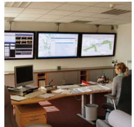
Verkehrsleitzentrale im Straßen- und Tiefbauamt
