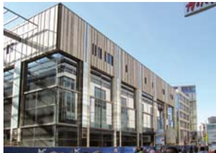
Neubau des Einkaufszentrums Centrum Galerie
