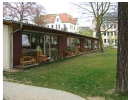
Erweiterung Kindertagesstätte Niederwaldstraße
