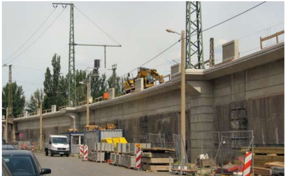
Stützmauer Bahnanlage Gutschmidstraße, Hechtviertel
