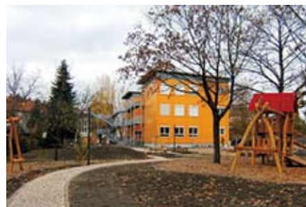
Sanierung Kindertagesstätte Industriestraße
