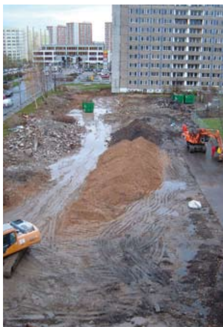
Aufwertung Elsterwerdaer Straße – während der Sanierung
