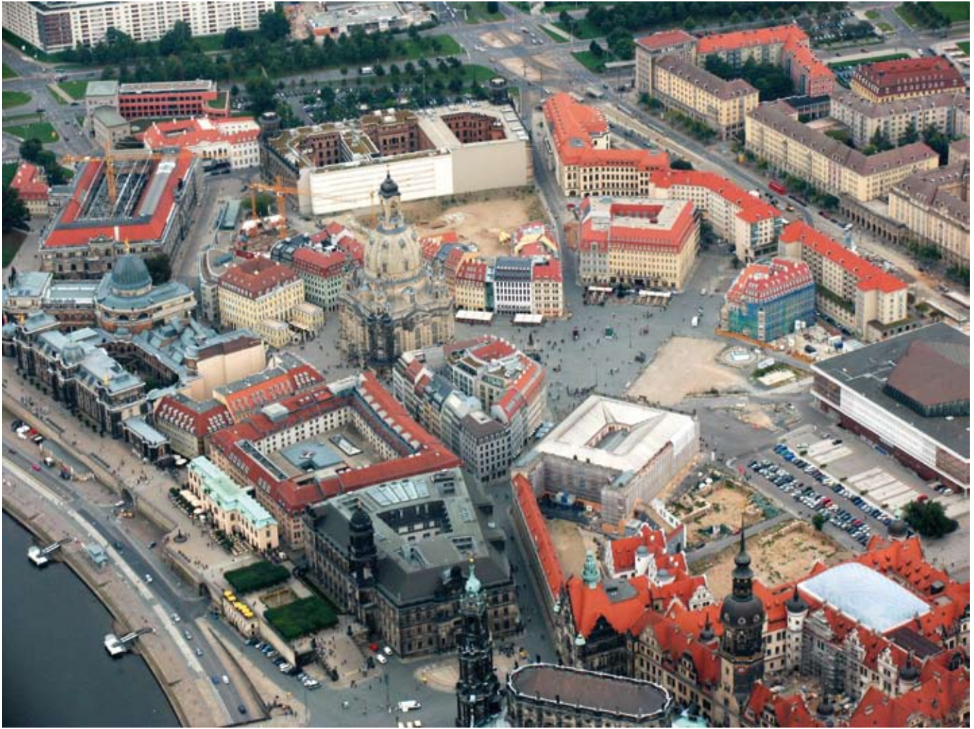
Schrägluftbild vom Neumarkt in östlicher Richtung
