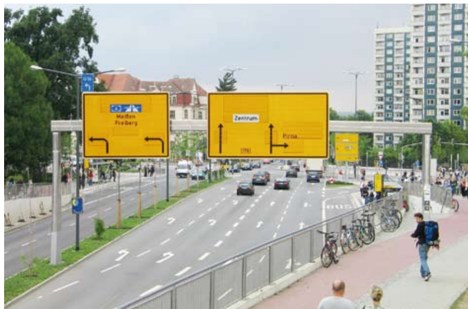
Dynamischer Wegweiser – Knotenpunkt Fritz-Foerster-Platz, Südzufahrt Bergstraße
