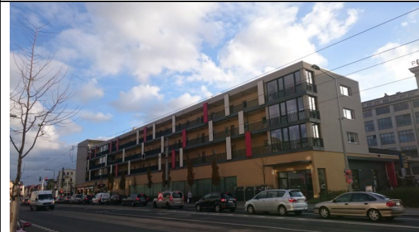
Bild 65: Verbrauchermarkt Edeka mit Wohnungen in den Obergeschossen (ES)
