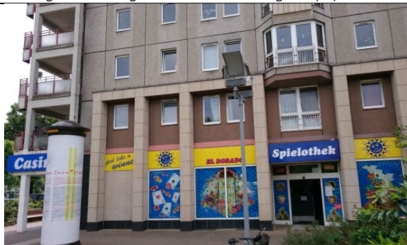
Bild 7: Situation St. Petersburger Straße/Ecke Ferdinandplatz (ES)
