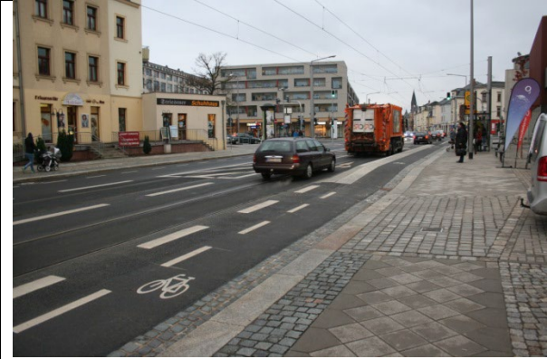
Bild 63: grundhaft sanierte Schandauer Straße mit behindertengerechter Haltestelle (JG)
