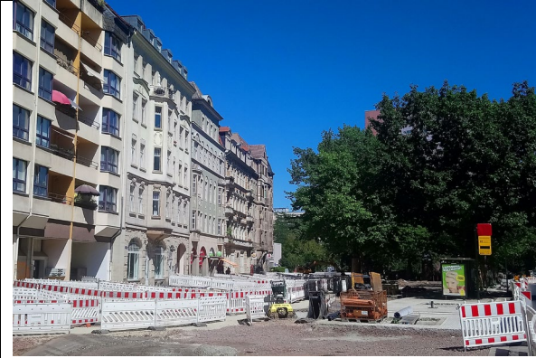
Bild 71: Bauarbeiten zur Aufwertung des Bönischplatzes mit Mitteln des Fördergebiets Soziale Stadt „Nördliche Johannstadt“ (ES)
