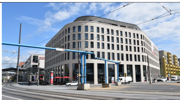
Bild 15: 2019 fertiggestelltes „Haus am Postplatz“ (ES)
