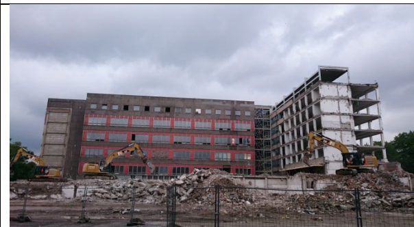
Bild 23: Abriss des Bürokomplexes an der St.Petersburger Straße/Lingnerallee für neue Wohnbebauung „Stadtquartier Blüherpark-West“ (ES)
