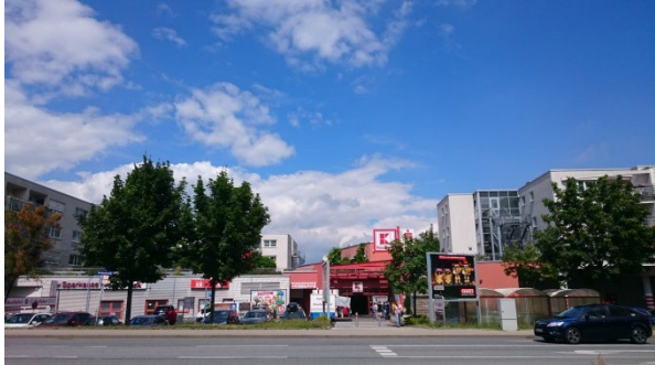
Bild 101: WZ Kohlenstraße mit Blick von der gegenüber liegenden Seite der Kohlenstraße (ES)
