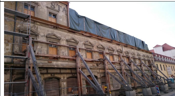
Bild 21: gesicherte Ruine des ehemaligen Hotels „Stadt Leipzig“ an der Heinrichstraße/Rähnitzgasse (ES)
