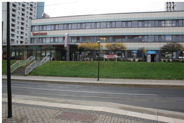
Bild 126: Dienstleistungsgebäude südlich der Räcknitzhöhe (JG)
