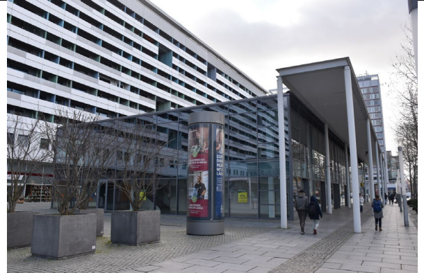
Bild 10: Leerstandssituation im mittleren Bereich der Prager Straße (ES)
