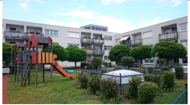
Bild 102: Dachbegrünung mit Spielplatz auf dem Erdgeschoss mit umliegenden Wohnungen (ES)
