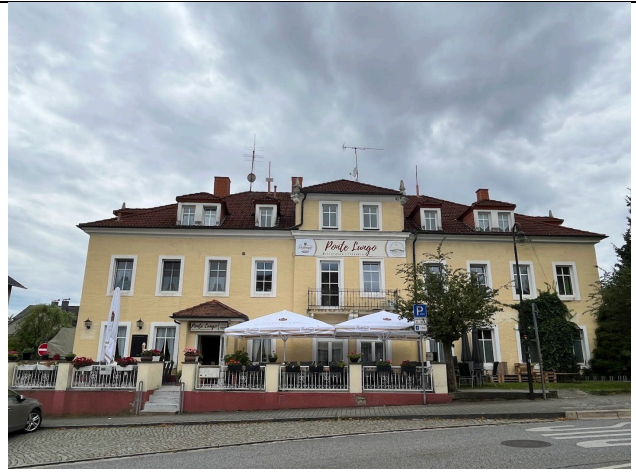
Bild 108: aufgeweiteter Bereich der Dresdner Straße mit Restaurant im Hintergrund (ES)
