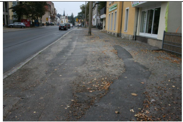
Bild 104: Gehwegsituation in Höhe Königsbrücker Landstraße 52 (JG)
