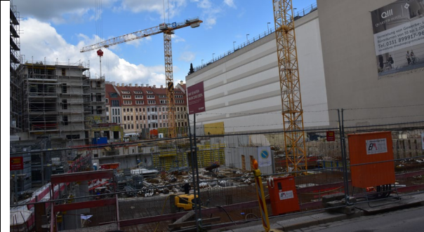
Bild 17: Mit der Errichtung des „Palais Hoym“ wird die letzte große Baulücke am Neumarkt geschlossen. (ES)
