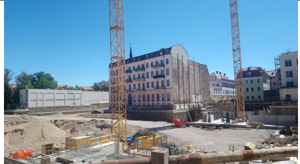
Bild 20: Errichtung von Wohnbebauung auf ehemaliger Brache am Palaisplatz (ES)
