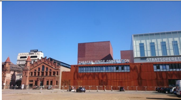
Bild 13: umgebautes Kraftwerk Mitte (ES)
