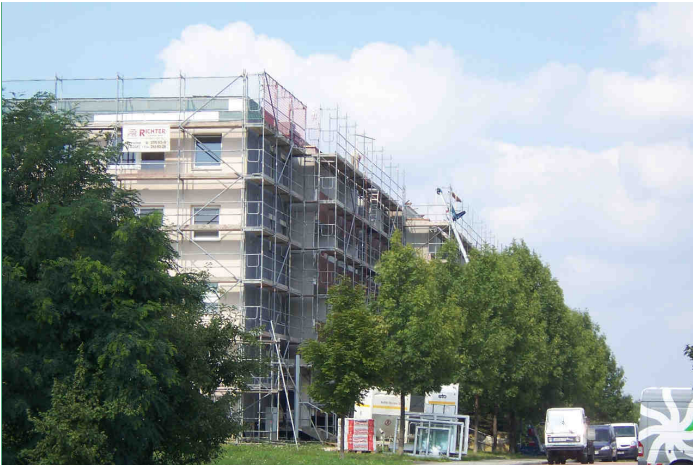
Rückbauarbeiten am Omsewitzer Ring
