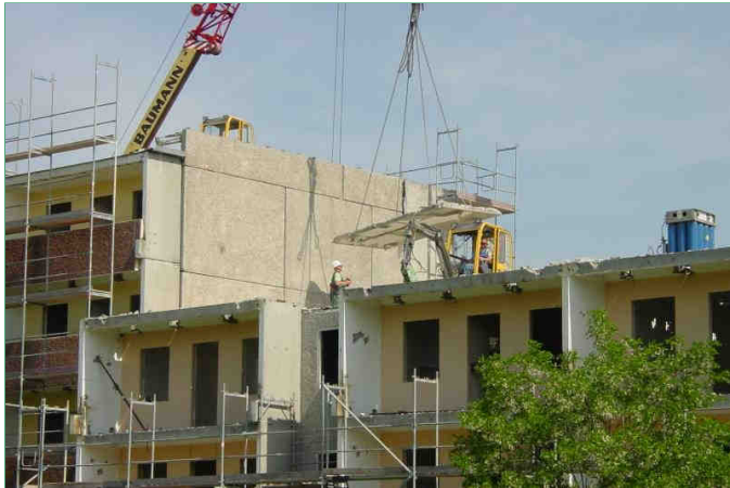
Rückbauphase der Plattenbauten in der Kräutersiedlung
