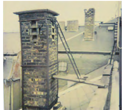
Beispiel Görlitzer Straße 25: Die Schornsteine waren teils einsturzgefährdet, teils zerstört und abgetragen. Heizen konnte man die Wohnungen darunter kaum noch.
