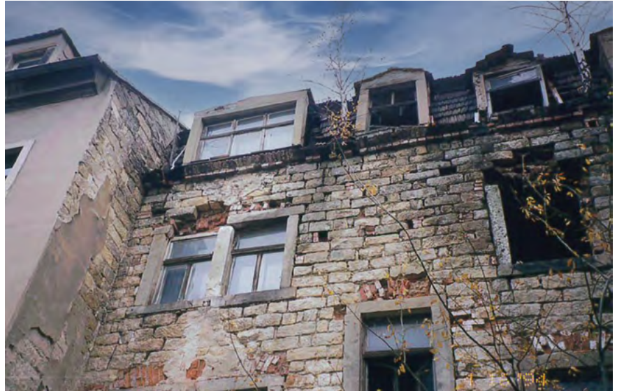
»Aufgeblühtes« Dach, kaputte Gauben, zerstörte Fassade in der Wolfsgasse 1 im Jahr 1994
