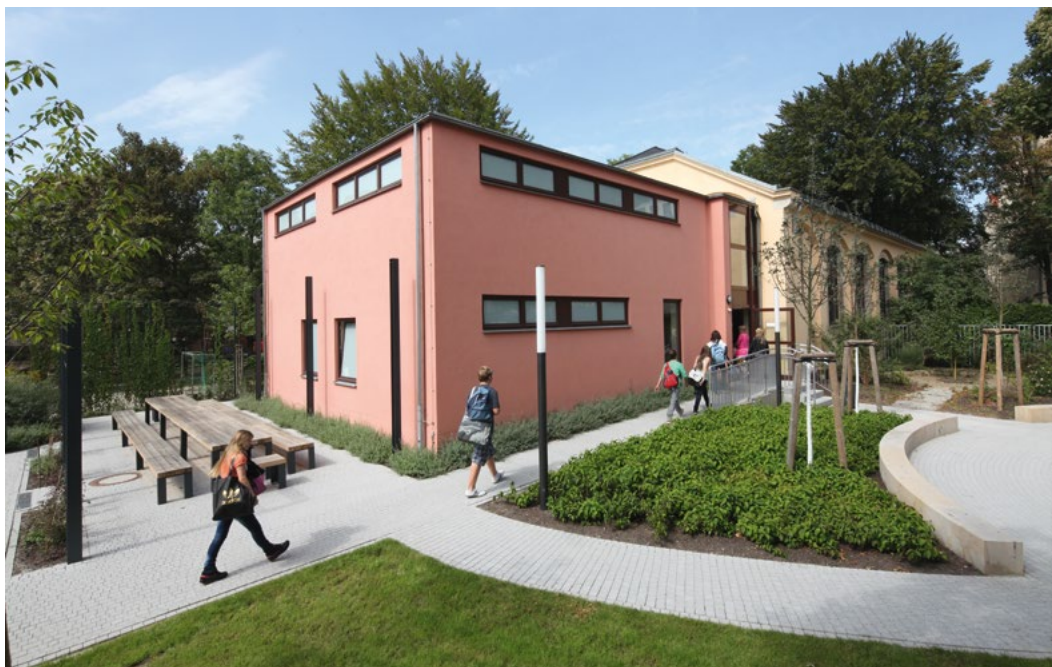
Neuer Anbau an der Turnhalle der Gemeinschaftsschule Pieschen
