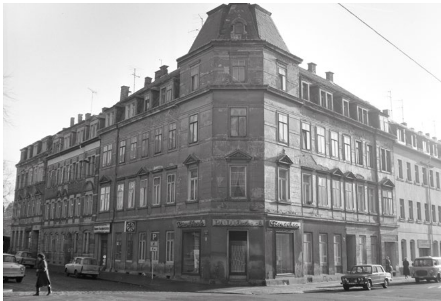
Auch das am Konkordienplatz gelegene Gebäude Oschatzer Straße 14 konnte mit Städtebaufördermitteln erworben und saniert werden. Nur so ließen sich langfristig günstige Mieten sichern.
