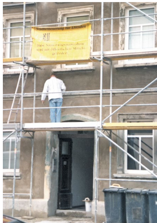
Das Banner »Stadterneuerung in Dresden« als Symbol für den Einsatz von Fördermitteln war in den Anfangsjahren der Sanierungstätigkeit ständige Begleitung. Quelle: Amt für Stadtplanung und Mobilität
