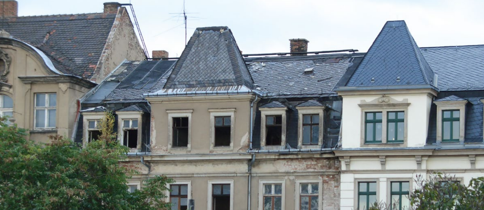
Alt und Neu, hier auf der Bürgerstraße. Diese Bilder prägten jahrelang das Sanierungsgebiet.
