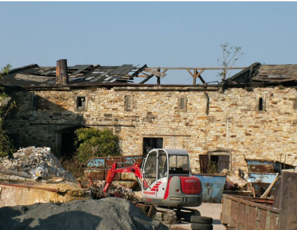
Ostravorwerk: unbrauchbares Dach
