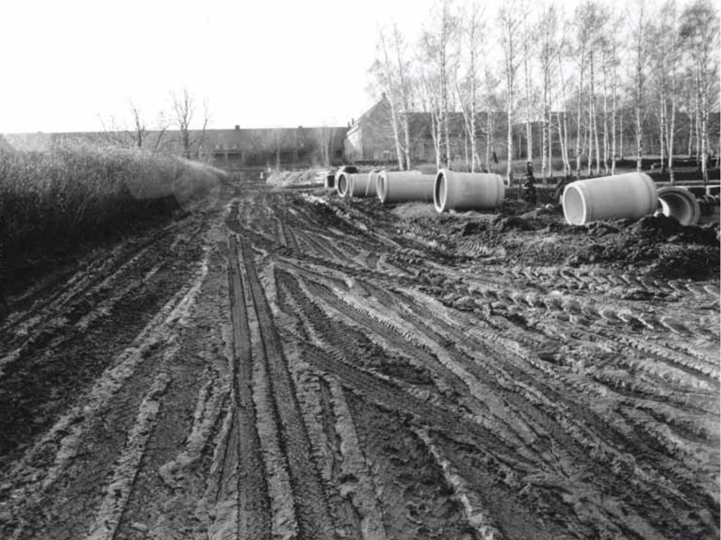
Erschließungsarbeiten an der heutigen Helena-Rott-Straße
