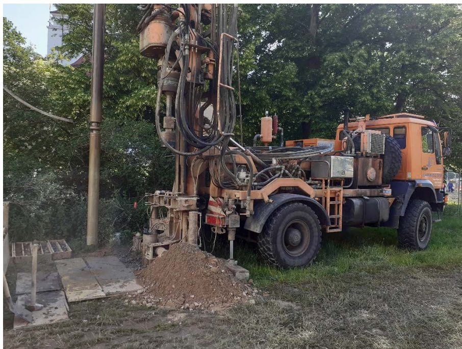
Abbildung 3.3: Abteufen der Baugrundbohrung am Aufschlusspunkt Bg 02/2020 mittels entsprechendem Bohrfahrzeug
