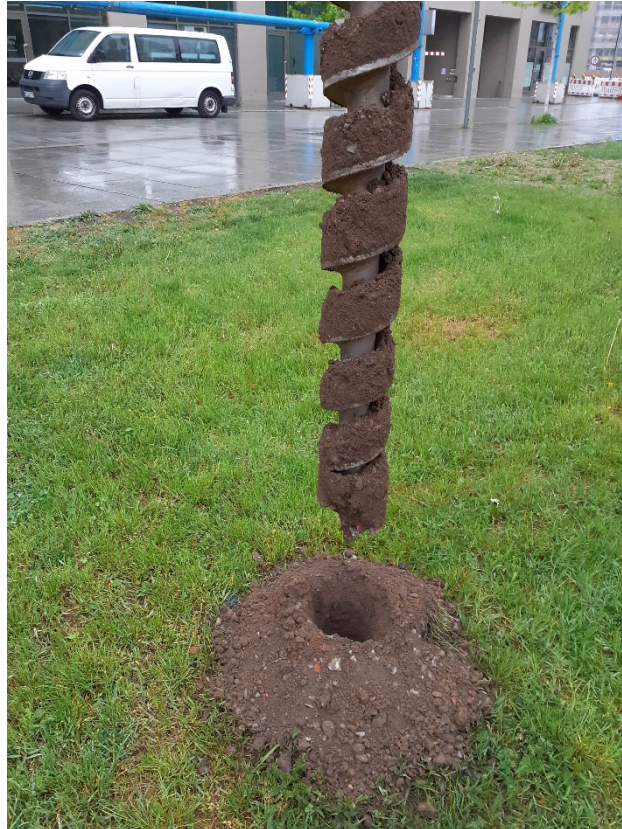
Abbildung 3.1: Abteufen des Sondierbohrlochs mittels Bohrschnecke für Kampfmittelfreigabe am Aufschlusspunkt Bg 04/2020
