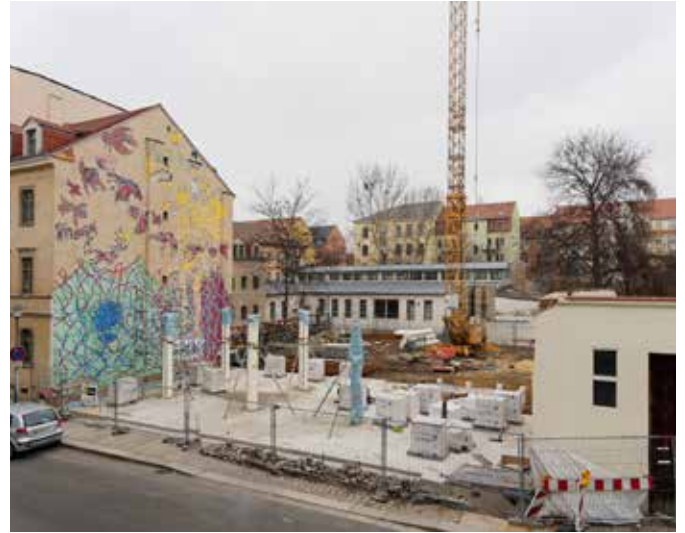
Baufortschritt nach dem Winter 2012/13
