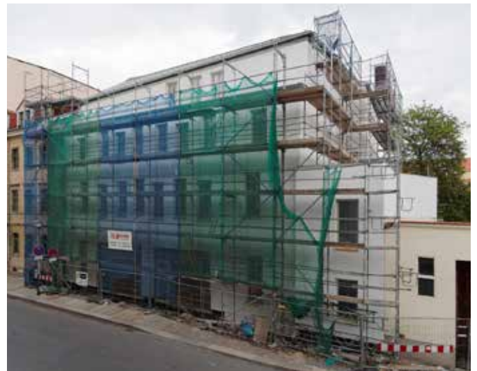
und ist im Rohbau bald fertiggestellt
