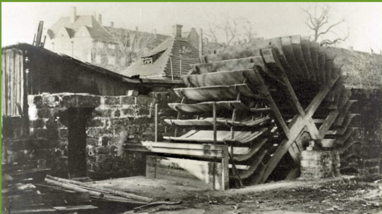
Letztes Wasserrad (Zuppinger Rad) auf dem Areal der früheren Pulvermühle kurz vor dem Abbruch 1937/38, es diente mittels unterirdischer Transmissionswelle dem Antrieb einer Getreidemühle und einer Schlosserei (siehe Lageplan oben), Archiv W. Müller
