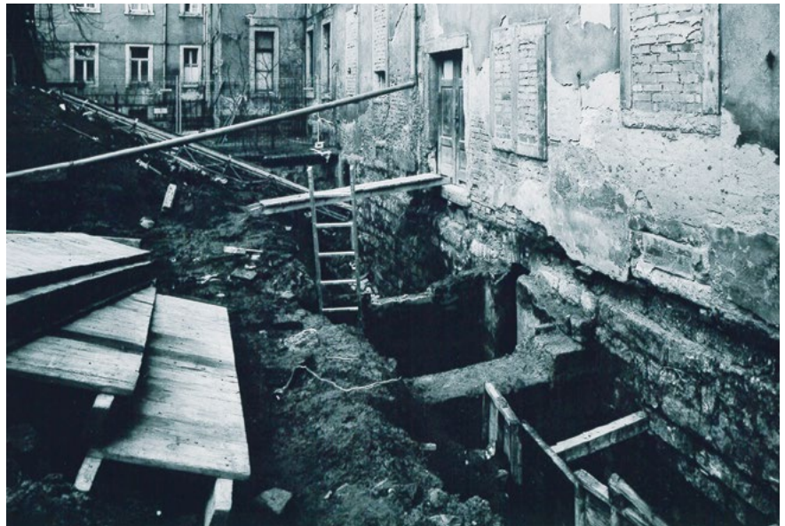
Fichtenstraße 12 Trockenlegung 1995 Quelle: Atelier Starke Fotografen
