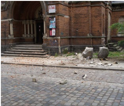
Birkenwurzeln drangen in das Mauerwerk des Turmes ein, so dass es dort zu Lockerungen und zum Absturz von Mauerwerk kam
