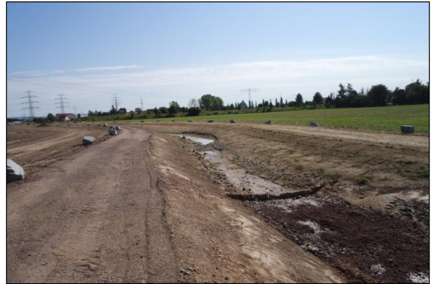
Bild 7: Zustand nach Fertigstellung unterstrom Kleinlugaer Straße
