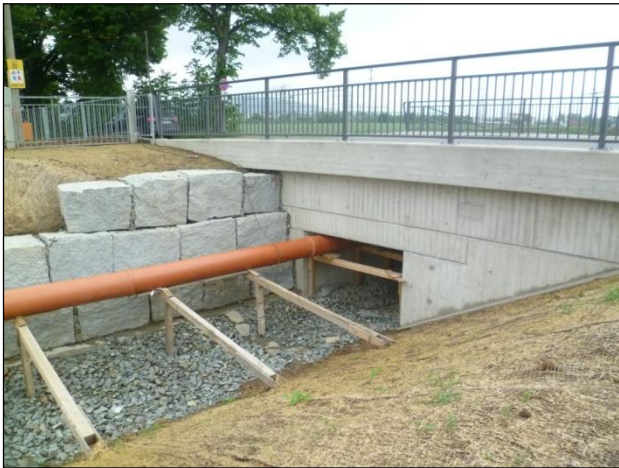
Bild 8: Ersatzneubau Brücke Kleinlugaer Straße
