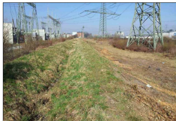
Bild 2: Urzustand am Umspannwerk
