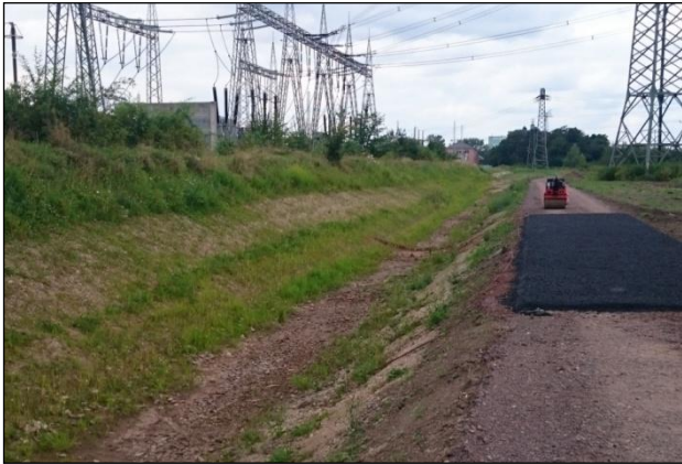
Bild 6: Zustand nach Fertigstellung am Umspannwerk
