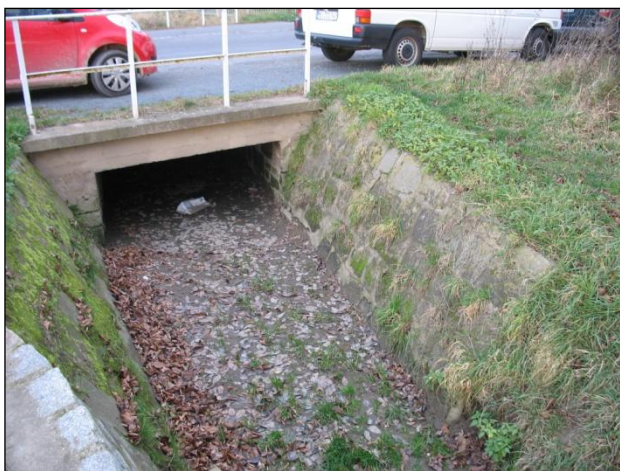
Bild 4: Urzustand Brücke Kleinlugaer Straße
