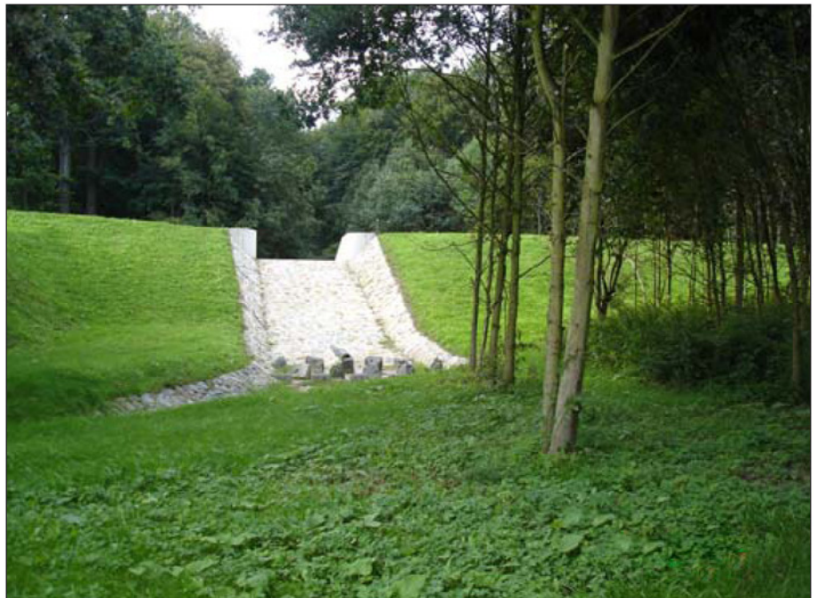
Abb.8: Hochwasserrückhaltebecken Maltengraben, Absperrbauwerk
