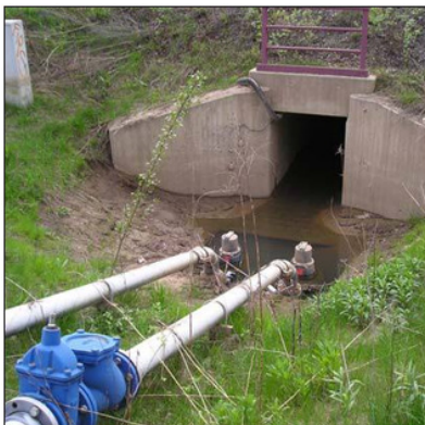
Abb.22: Auslaufbereich und Pumpensumpf Düker Bahndamm
