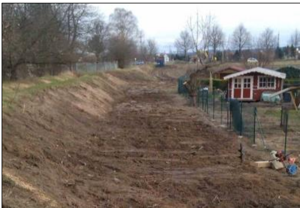
Bild 5: Rückbau Kleingärten Januar 2015
