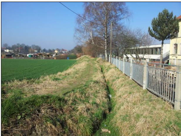
Bild 4: Istzustand im Bereich 90. Grundschule
