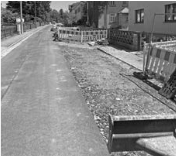
Baumaßnahme Stiehlerstraße Langebrück
