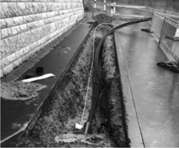
Verlegung Kabel DREWAG
