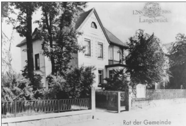
Das Gemeindeamt Schillerstraße 5
