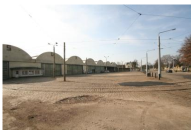
Historischer Straßenbahnhof und Gleise Wehlener Straße
