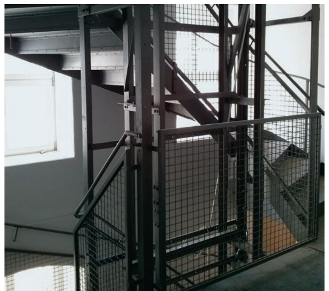
39 In der Roggenmühle konnte die ehemalige Stahltreppe, in deren Treppenaue sich ein Sackaufzug für den Roggen befand, samt der Aufzugkonstruktion erhalten werden.
