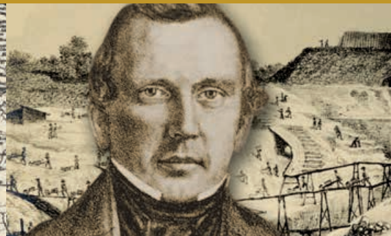
Obersteiger Schneider leitete für diese Strecke den Bau des ersten deutschen Eisenbahntunnels.
