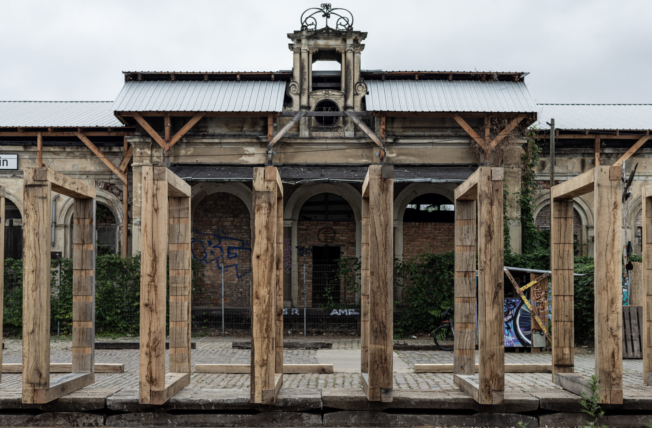
Blick auf den Mittelrisalit mit Zugang zum möglichen Veranstaltungsraum
