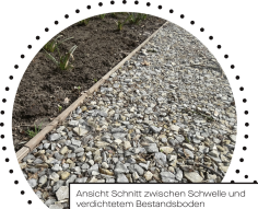
Abschnitt Schnitt zwischen Schwelle und verdichtetem Bestandsboden
