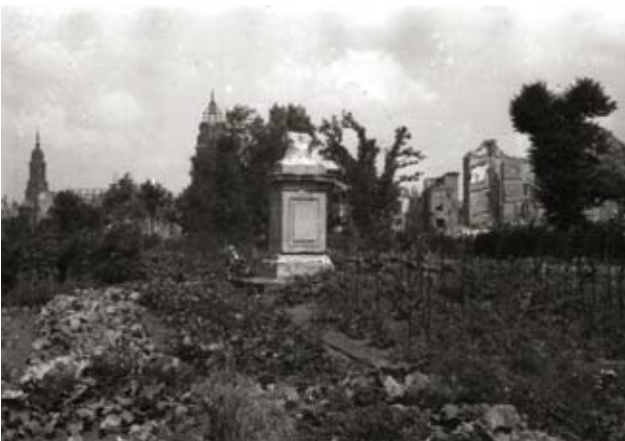
Abb. 3: Die Bürgerwiese nach der Zerstörung 1945
