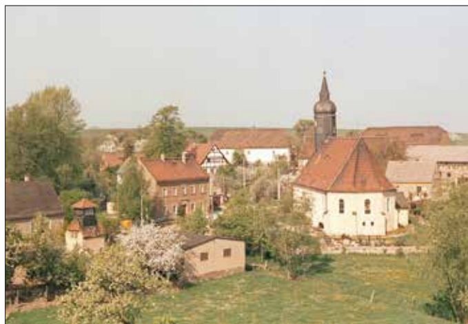
Im Bild links das Trafohaus
