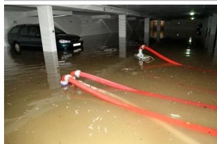
Bei Tiefbauarbeiten mit einem Bagger wurde eine Hauptwasserleitung im Bereich des Schänkenweges beschädigt. In Folge dessen kam es zum massiven Wasseraustritt, was zum Wassereinbruch in eine Tiefgarage führte. BF setzte im ersten Moment eine TP 4 sowie die Turbo-Lenz-Pumpe des HLF ein. Nach Anforderung des AB-Pumpen und einer STF, wurden drei weitere Pumpen eingesetzt. In der Tiefgarage waren noch ein Ford-Kombi und ein Audi-Kombi abgeparkt, bei denen das Wasser bis zu den Schwellern stand.
