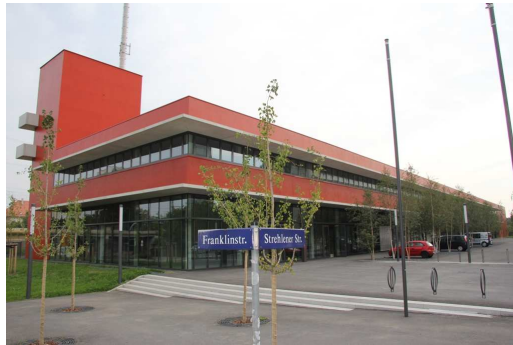
Eingangsbereich der Feuerwache
