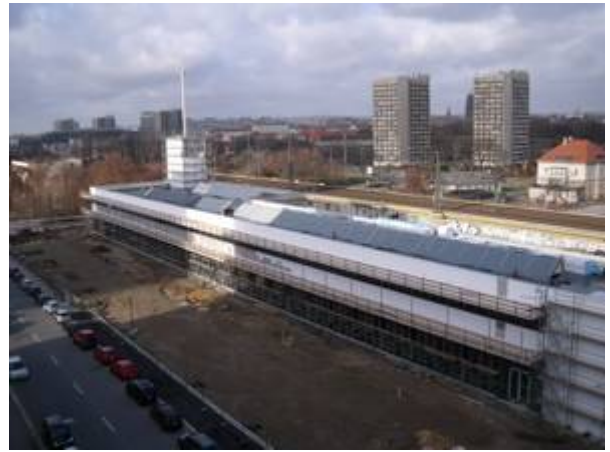
Die Baustelle im Januar 2012
