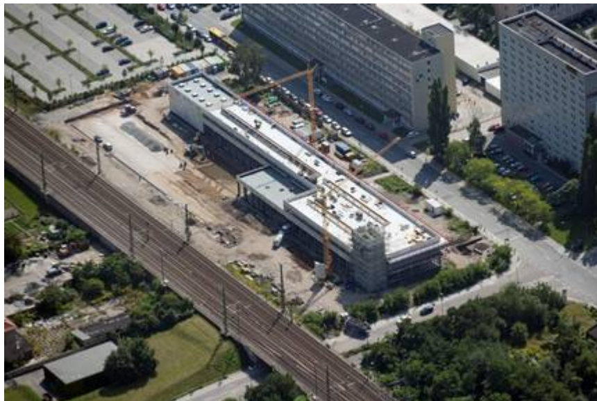
Luftbild mit Blick auf die Baustelle der Citywache – im Vordergrund die Bahnstrecke – parallel dazu die Strehleener Straße mit der Kreuzung Franklinstraße – Jahresmitte 2011 – Foto: STESAD
