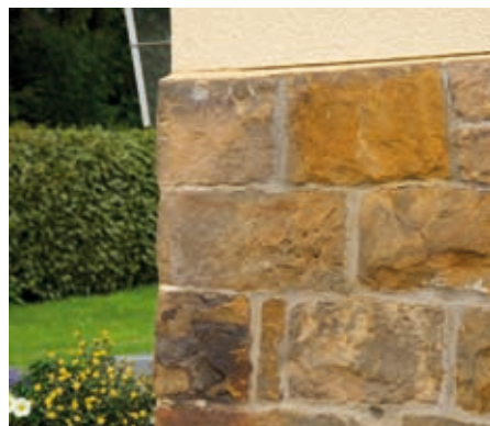
27 Sanierter Sockel ohne Verblechung
