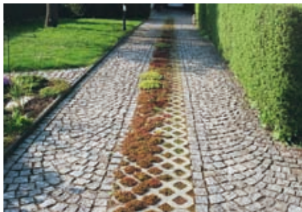
83 Zufahrt mit Granit-Kleinpflaster und offenem Mittelstreifen
