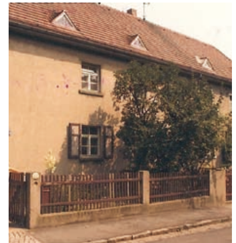
71 Einfriedung ‚Auf dem Eigen‘ mit geradem Abschluss, 1927
