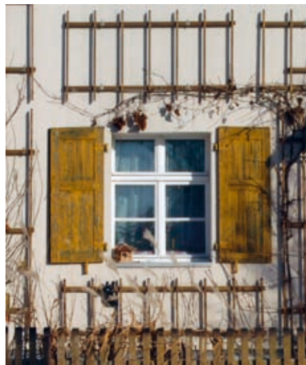
50 Fensterladen ohne Schmuckform, 2. Bauabschnitt
