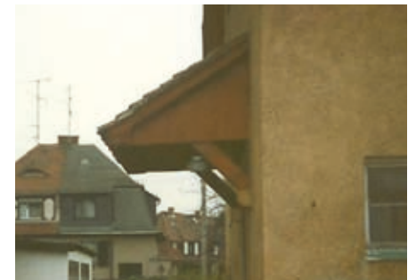
61 Vordach als Schleppdach, geschlossene Seitenflächen, 1. BA
