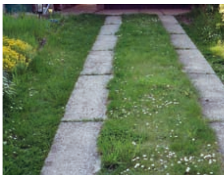
84 Rasen mit befestigter Fahrspur
