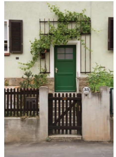
79 Einfriedung mit Gartenpforte und schmaler Mauer zwischen den Säulen für den verdeckten Müllstandort, 2./3. BA
