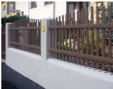
74 Betonsockel und Zaun, 1. Bauabschnitt, Rekonstruktion
