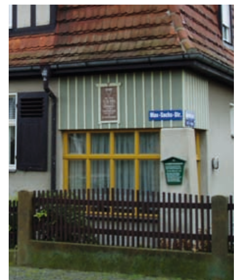
39 Senkrechte Holzschalung über den Eckloggien
