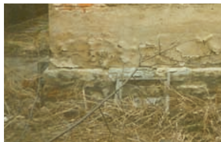
25 Sockel aus Pläner an Häusern des 1. Bauabschnitts
