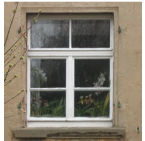
47 2-flügeliges Fenster mit Oberlicht, EG, 2./3. Bauabschnitt
