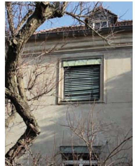
53 Originale Jalousie im 1. OG mit Blende, 2. Bauabschnitt
