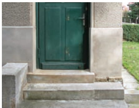
67 Treppe mit 3 Betonblockstufen und seitlicher Wange, 1. BA
