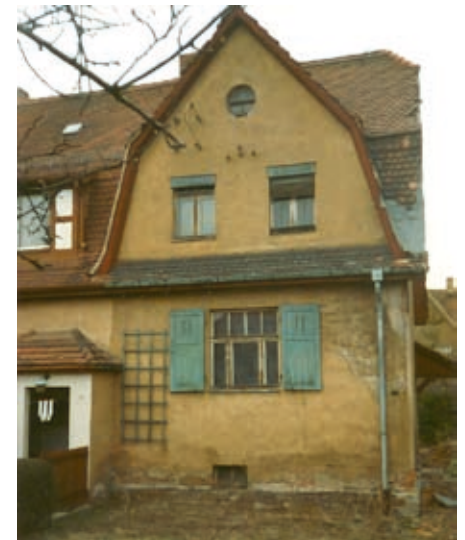
29 Originale Farbgebungen, 1. Bauabschnitt
