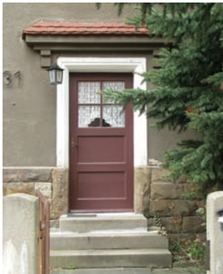
57 Hauseingangstür mit Türgewände, 1924, 3. Bauabschnitt
