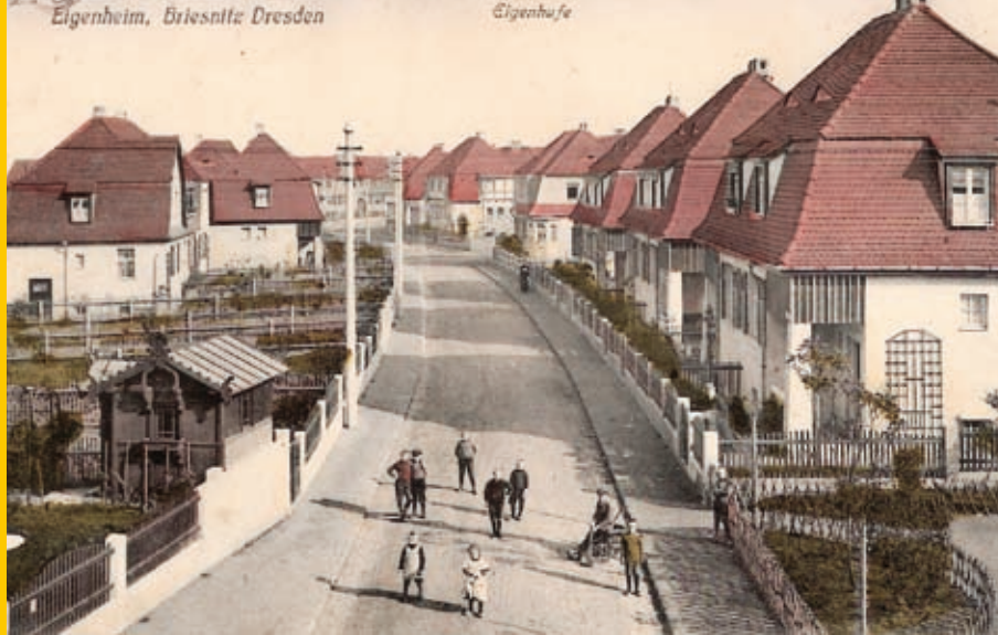
26 Blick in die Eigenhufe vom Haus Vierlinden 9/11/13, um 1913
