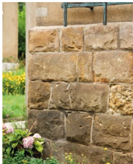
26 Sockel aus bossierten Sandsteinquadern, 2./3. Bauabschnitt
