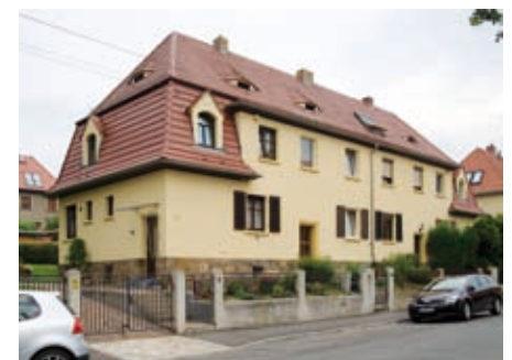
30 Einheitliche Farbgestaltung einer Hausgruppe
