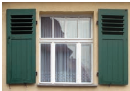
49 Fensterladen mit Lamellen im oberen Feld, 1. Bauabschnitt
