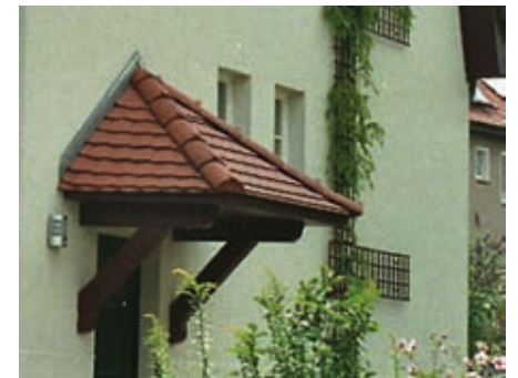
62 Vordach als Walmdach, 1. Bauabschnitt
