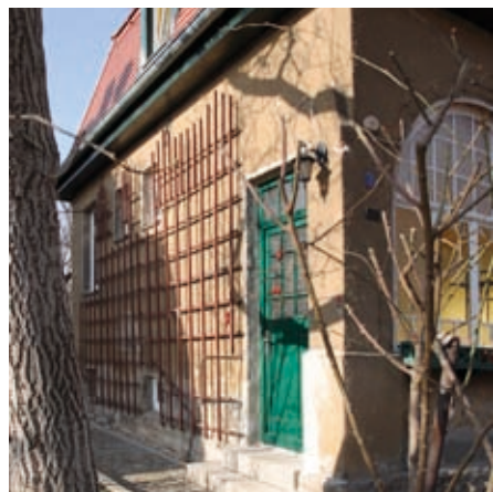
41 Spalier an der Seitenfassade
