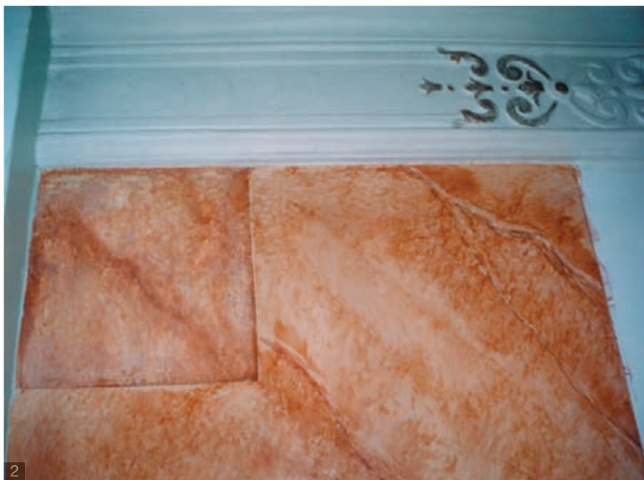
2 Wandssockel mit rekonstruierter Marmorierung und Befundfenster
