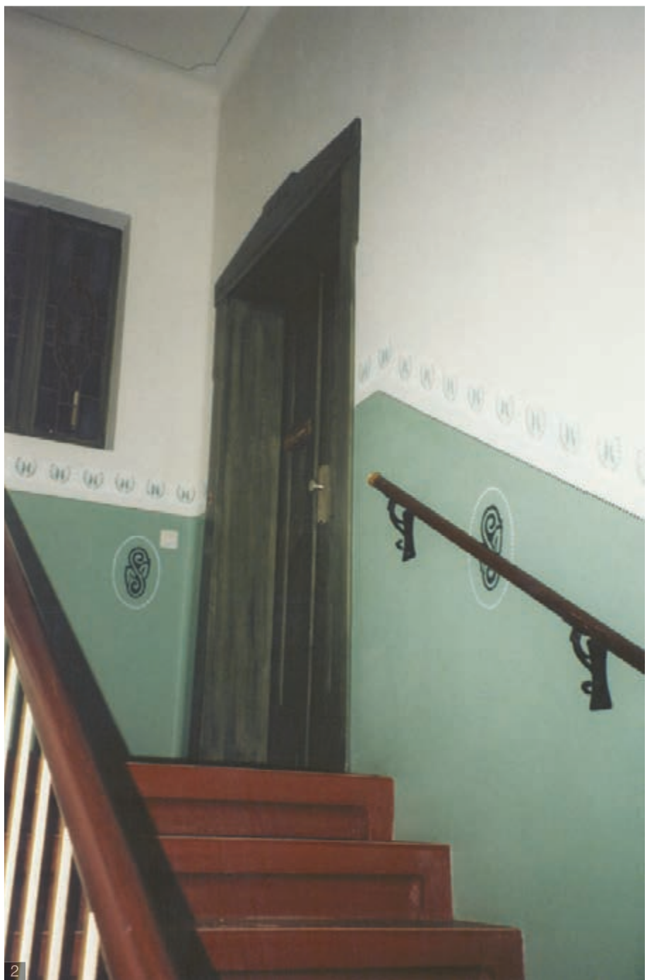
1 Blick ins Treppenhaus vor der Instandsetzung 2 Das Treppenhaus nach der Rekonstruktion
