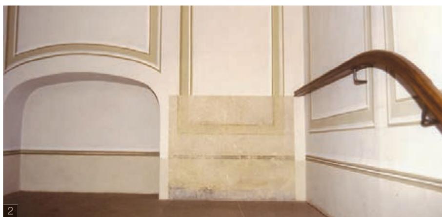
1 Das Treppenhaus vor Rekonstruktion der historischen Fassung
