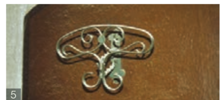
3 Stollsestraße 66, Erfassung wichtiger Ausstattungsdetails - hier einer Handlaufhalterung in Jugendstilformen
