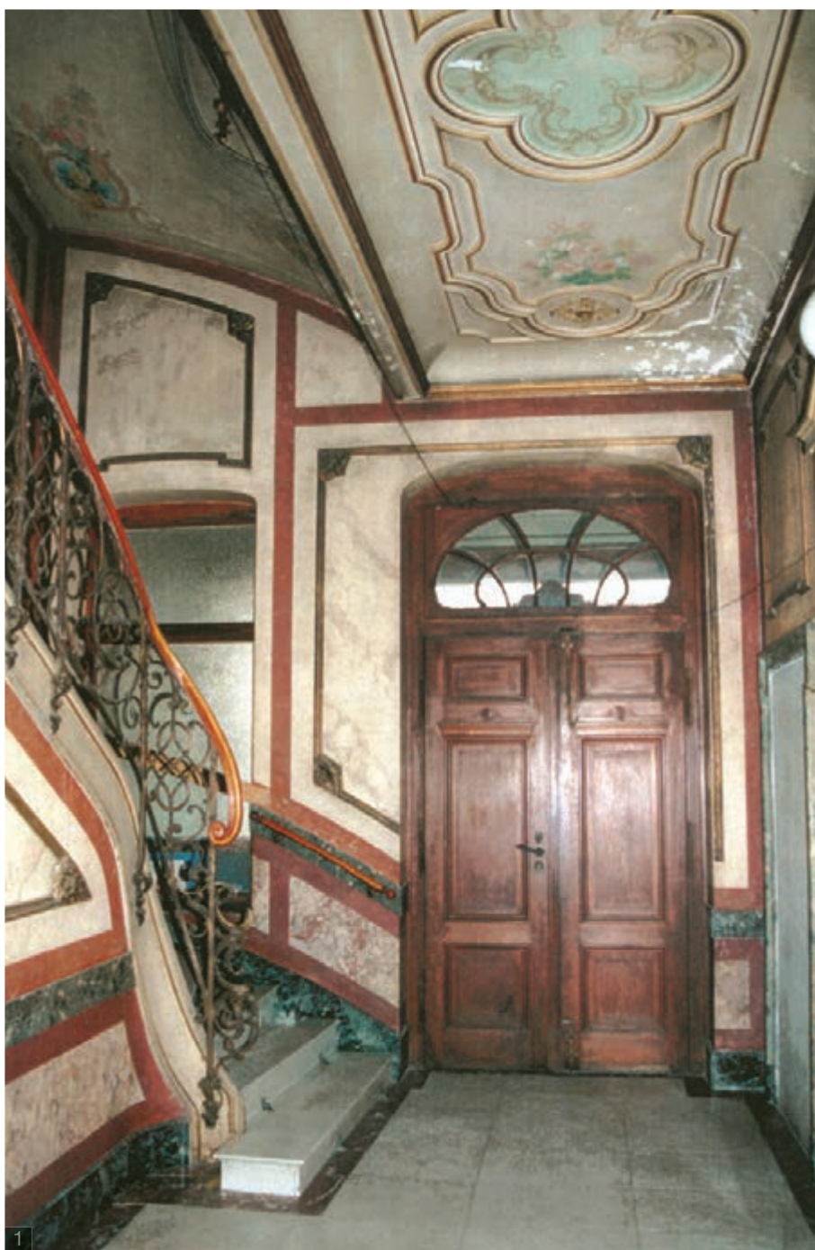
1 Treppenhaus mit Blick in Richtung Hauseingang vor der Instandsetzung
