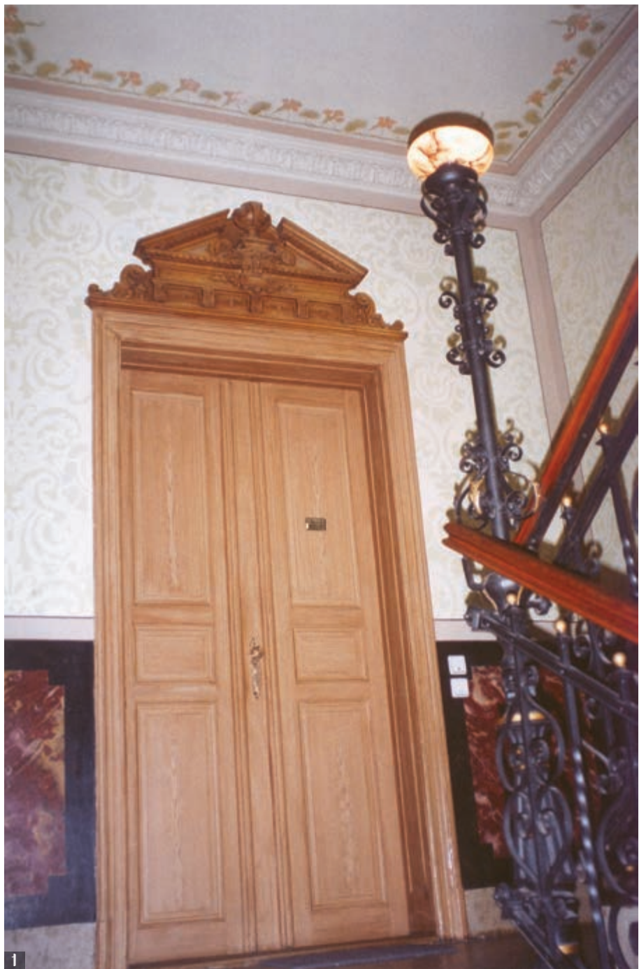
1 Blick in das Treppenhaus mit Wohnungseingangstüre, Wanddekoration und Beleuchtungskörper
