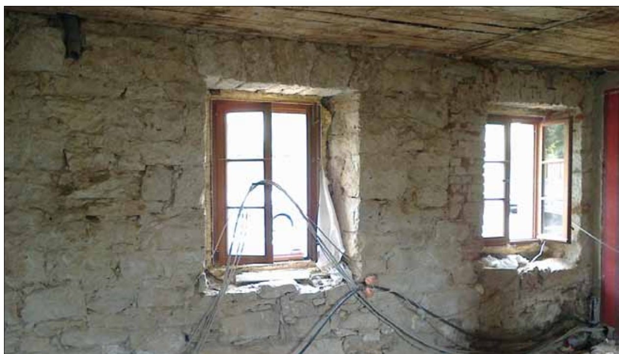
Bei Sanierungsarbeiten im Jahr 2012 wurde die Baufuge zwischen dem Altbau von 1828 und der Erweiterung von 1858 am Wechsel von Sandstein und Ziegelmauerwerk neben dem rechten Fenster wieder sichtbar, Foto: Dirk Schumann
