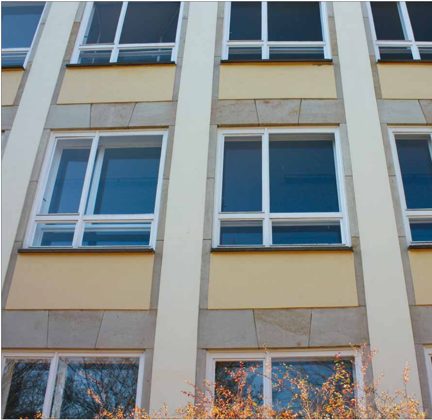
Fast alle Kastendoppelfenster des Gebäudes befanden sich noch im Originalzustand., Foto: Claudia Posselt
