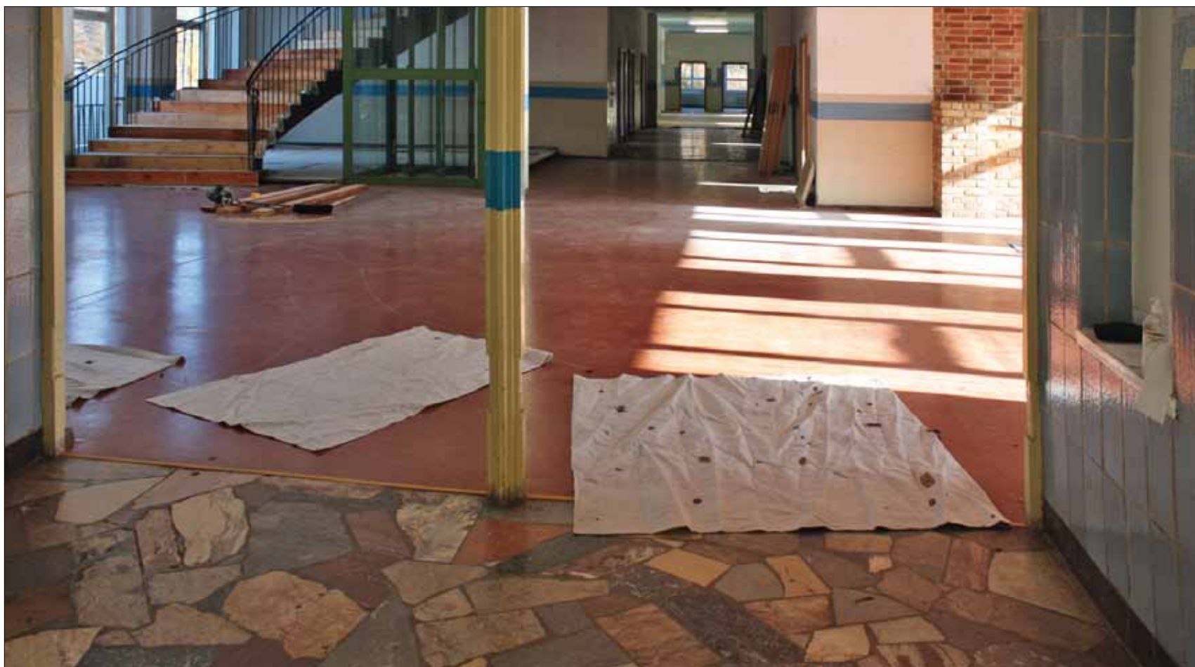
Blick in das Foyer kurz vor Baubeginn. Der im Vordergrund erkennbare Natursteinboden und die Wandfliesen im Windfang blieben erhalten, der dünne Terrazzobelag der Haupttreppe ist bereits zum Schutz mit Brettern abgedeckt, Foto: Claudia Posselt
