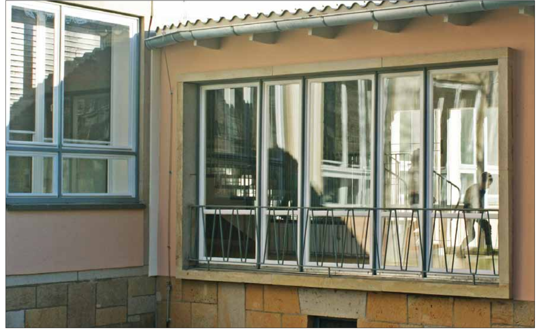
Aufgearbeitete und modernisierte Fenster – die inneren Kastenfenster der Unterrichtsräume links erfüllen mit automatischen Sonnenschutzvorrichtungen und Isolierverglasungen aktuelle Standards des Wärme- und Schallschutzes, Foto: Dirk Schumann
