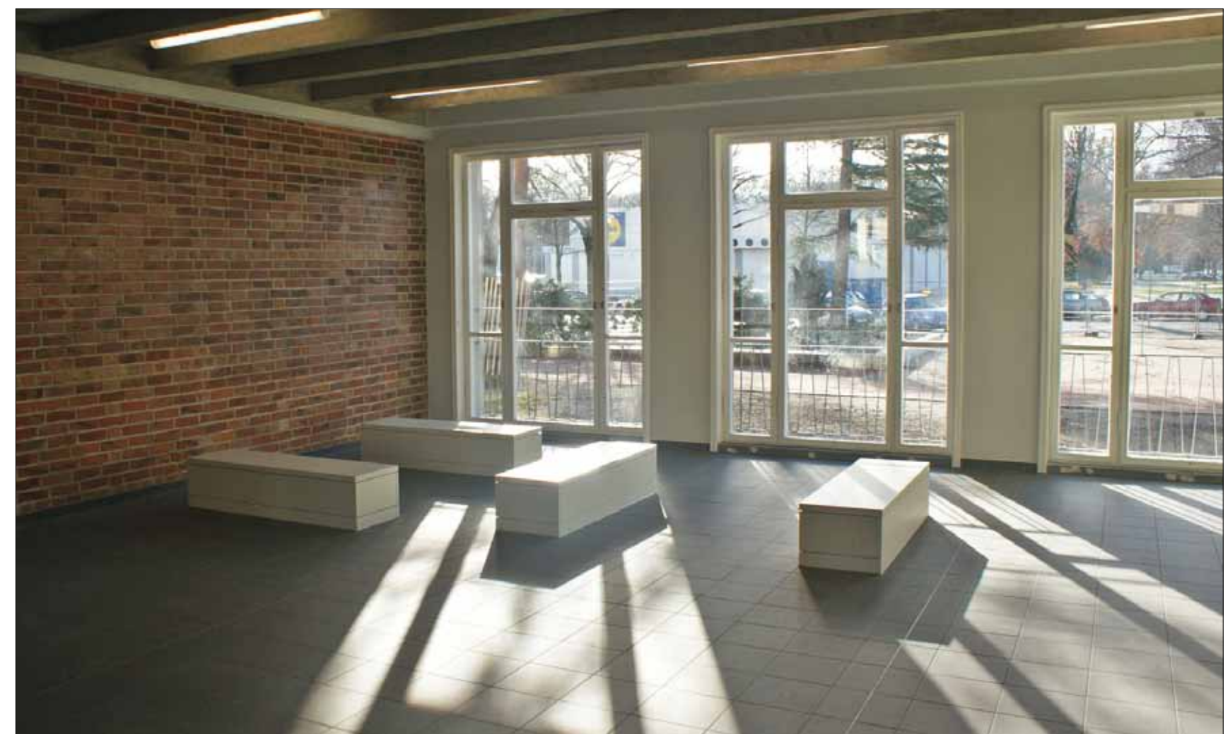
Foyer in Richtung Süden: Wand- und Deckenflächen befinden sich heute fast wieder im Originalzustand. Die Fußbodenbeläge mussten nach über 50 Jahren erneuert werden, Foto: Dirk Schumann
