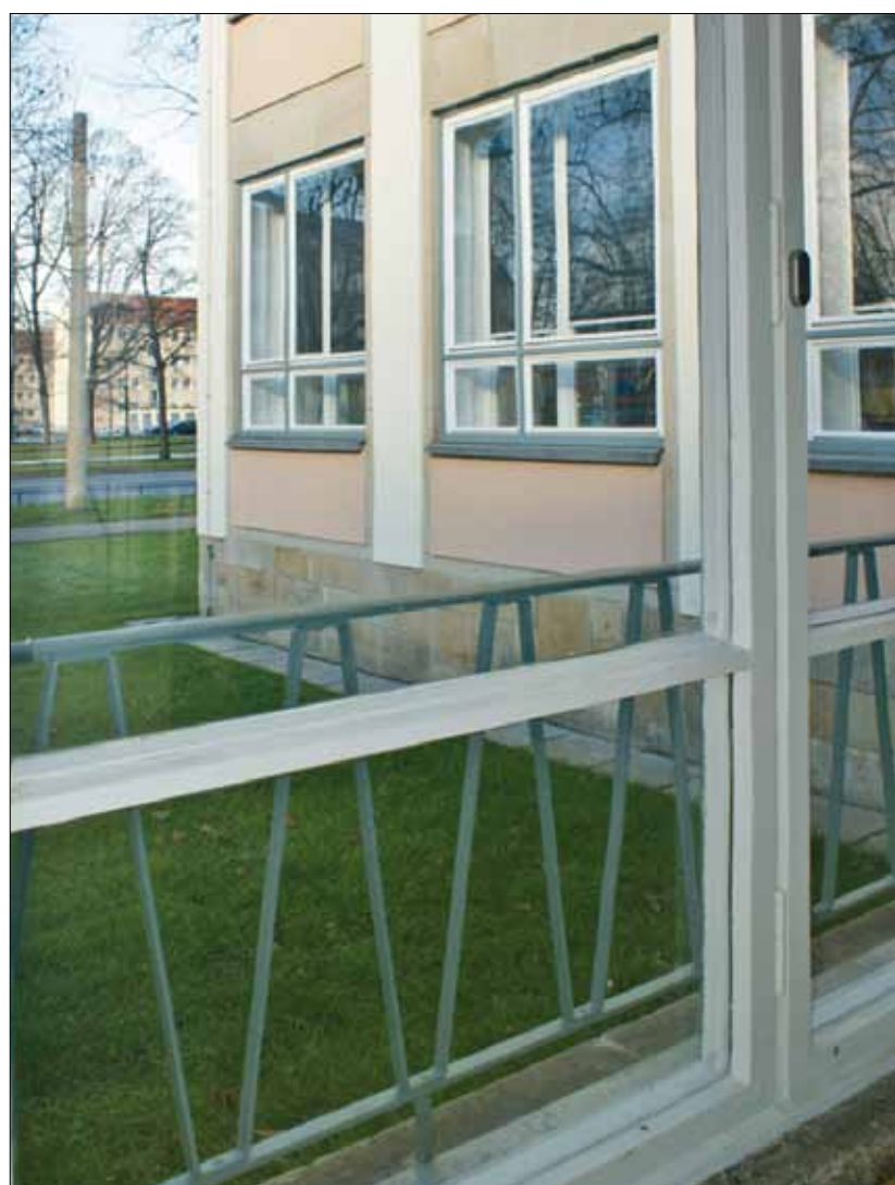
An den historischen Verbundfenstern der Verbinderbauten, der Flure und einiger Schul- und Büroräume reichte die denkmalgerechte Aufarbeitung, sogar die bauzeitliche Verglasung konnte zum großen Teil erhalten bleiben. Für die erforderliche Sicherheit sorgen aufgeklebte Splitterschutzfolien, Foto: Dirk Schumann
