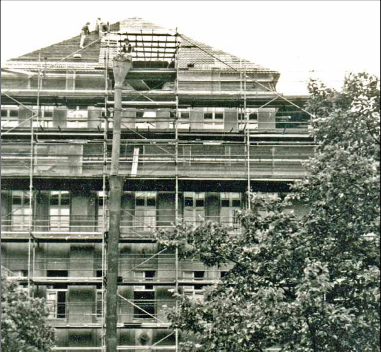
Neueindeckung des Daches 1987 – Die Dachdecker ersetzen die noch teilweise originalen Pfannen (rechts) durch flach liegende Biberschwanzplatten (links). Archiv Hans-Erlwein-Gymnasium
