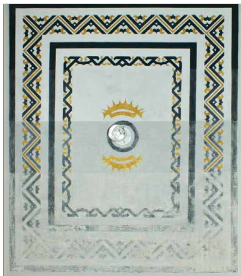
Die Decke der ehemaligen Mädcheturnhalle zeigt in einem Feld die Stufen von der Freilegung über die Retusche bis zur Restaurierung der Ausmalung.
