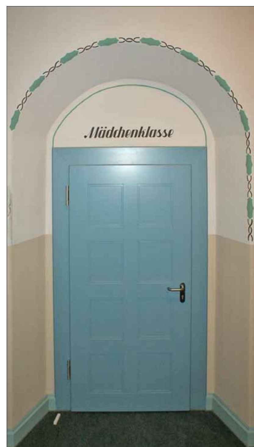
Denkmalgerecht erneuerte Klassenzimmertür mit freigelegter und rekonstruierter Wandfarbfassung
