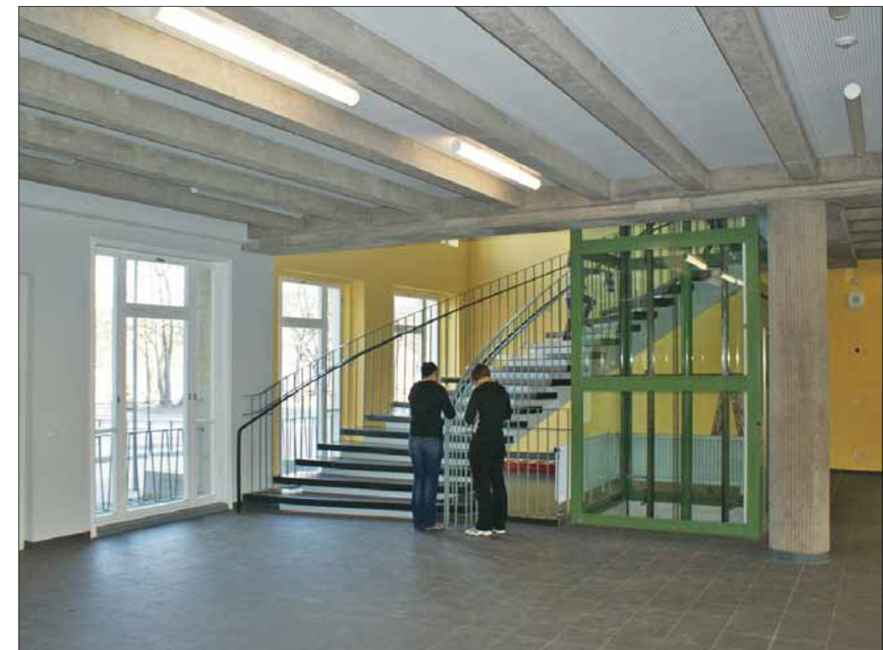
Foyer und Flur im Erdgeschoss mit der originalgetreu wiederhergestellten Wandfassung und den von späteren Anstrichen befreiten Deckenbalken, Unterzügen und Stützen aus Beton, Foto: Dirk Schumann
