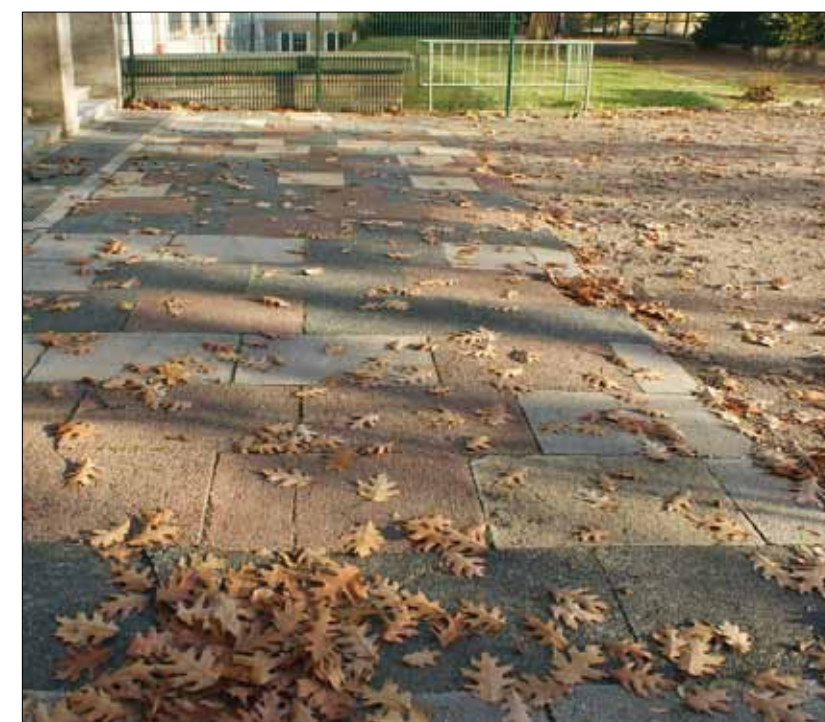
Ein Teil der ursprünglichen, in Rot, Gelb, Grau und Anthrazit gefärbten Betongehwegplatten konnte wieder verwendet werden, Foto: Dirk Schumann, 2013
