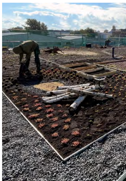
Auszubildende des städtischen Regiebetriebes bepflanzen das Dach an der Lohrmannstraße
