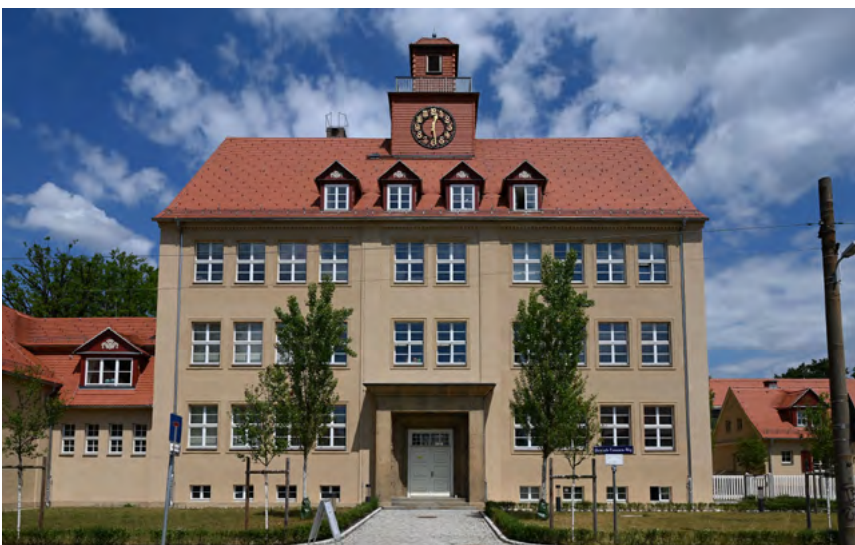
Sanierte 84. Grundschule „In der Gartenstadt“. Foto: Anja Schneider
